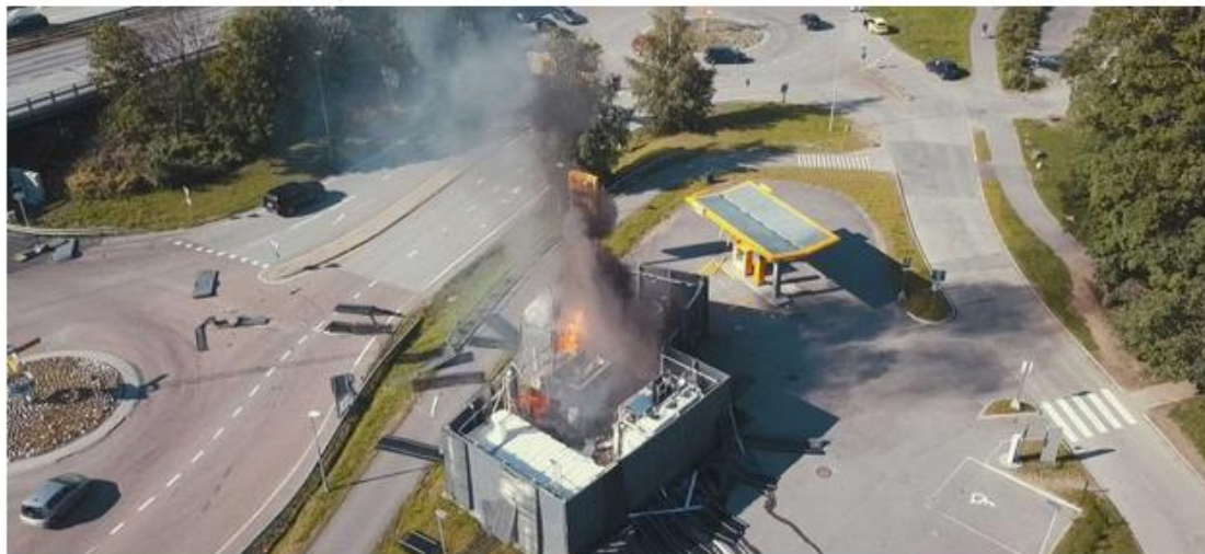
Figura 2.21 – Effetti della detonazione della stazione di rifornimento nei pressi di Oslo (Norvegia), 6 giugno 2019
