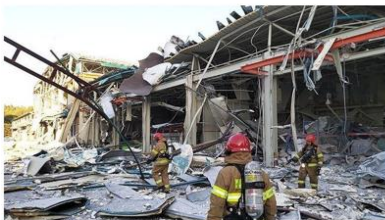
Figura 2.20 – Effetti dell'esplosione di un serbatoio di H_2 a Gangneung, 23 maggio 2019
