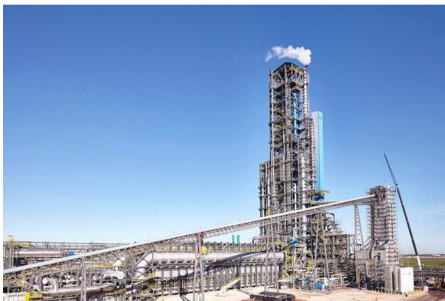
Figura 2.2: Vista esterna di un impianto industriale per la produzione di DRI mediante processo MIDREX. Sono visibili la struttura verticale del reattore di riduzione, le linee di trasporto dei materiali e parte delle infrastrutture ausiliarie del circuito gas. Immagine presa dal sito web: primetals.com
