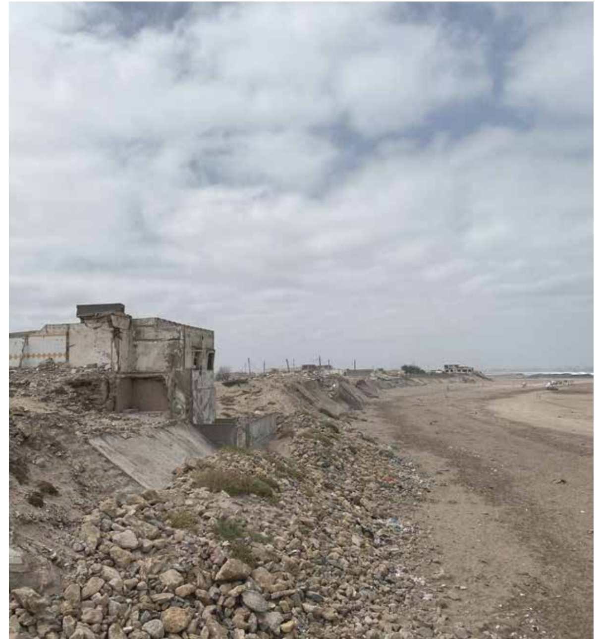
I lavori prevedono la liberazione di tutte le macerie e rendere accessibile la costa per la balneazione.
