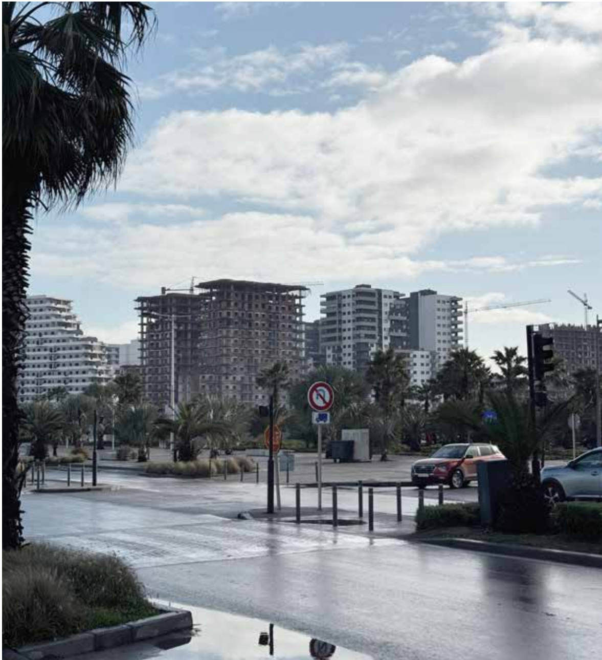
Edifici multipiano realizzati mediante tecniche costruttive innovative.
