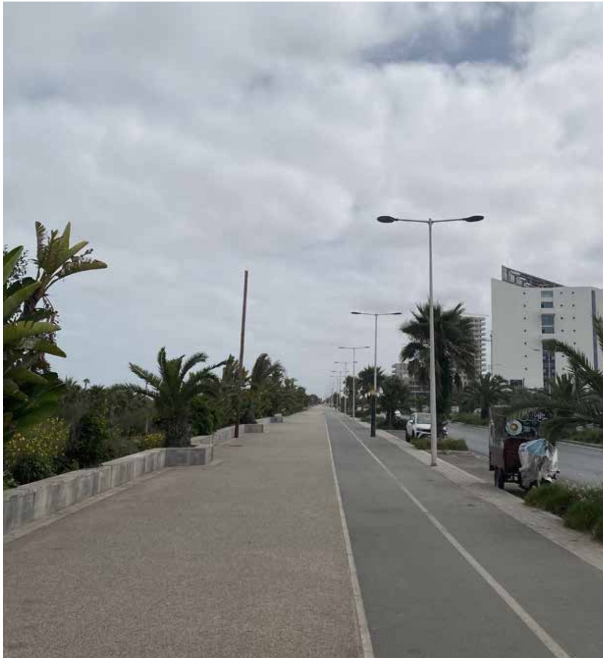
Particolare attenzione è stata dedicata alla sezione stradale, articolata in due corsie per senso di marcia, con pista ciclabile e percorso pedonale continui lungo l'intero progetto.
