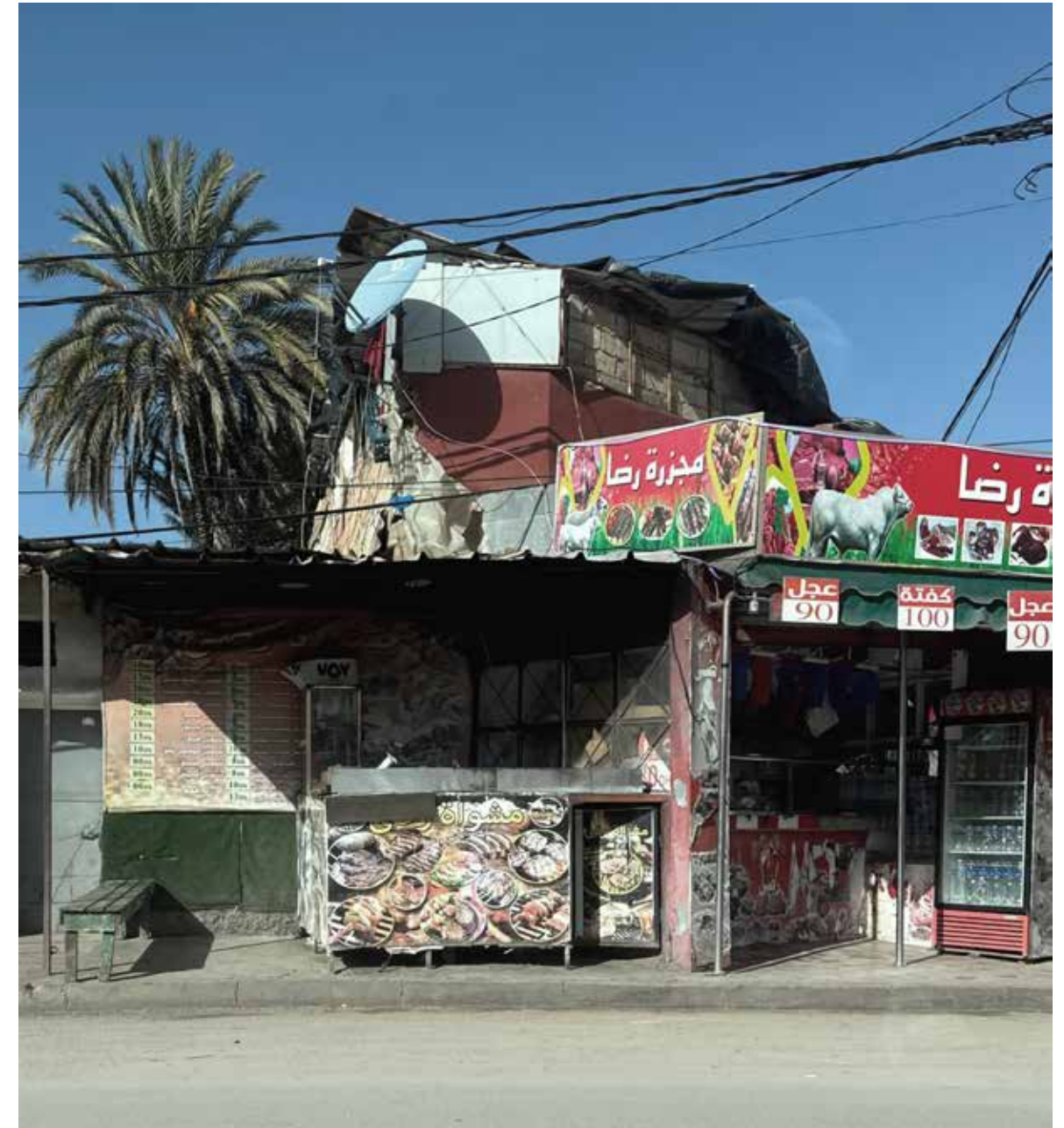
Attività di vendita al dettaglio al piano terra. Piano superiore occupato da alloggio.
