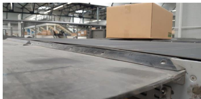
Figura 4.2.4 Vista C, deformazione del pianale di scorrimento della cella MBHS ® , in un impianto di prova, Leonardo S.p.A.
