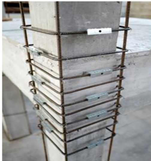
Figura 7: Esempio di rinforzo del nodo d'angolo mediante perforazioni armate e manicotti a chiodi [5].
