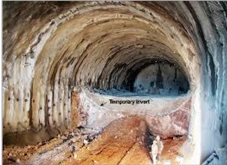
Figura 1.11: Zone di scavo a sezione parzializzata
