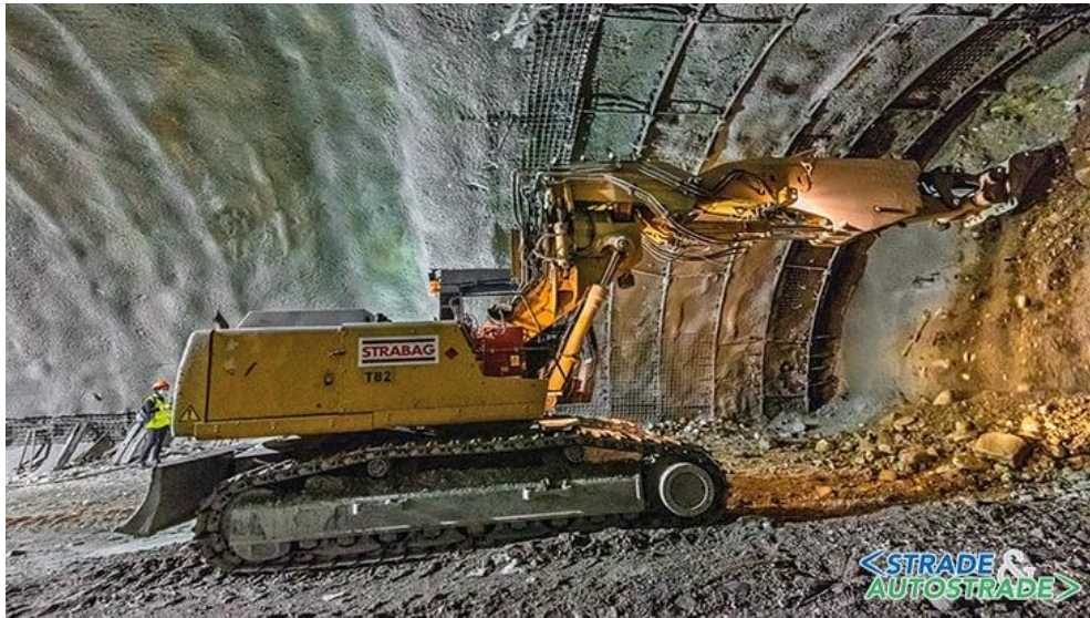
Figura 1.7: Attacco del fronte con escavatore
