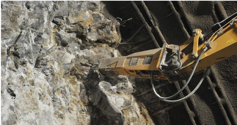
Figura 1.9: Attacco del fronte con martello idraulico montato su escavatore resistenza.
