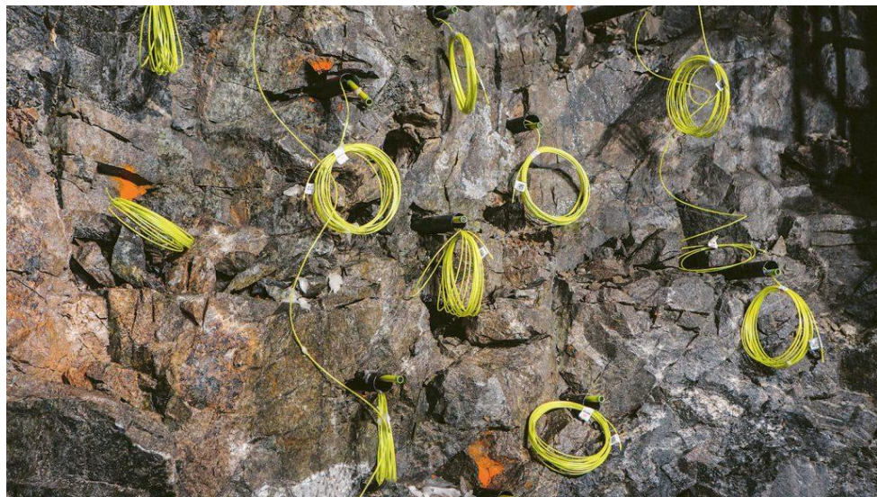
Figura 1.10: Attacco del fronte con esplosivo
