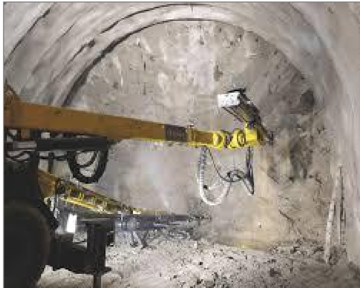
Figura 1.14: Installazione di elementi lineari con perforatore Jumbo
