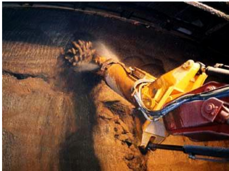
Figura 1.8: Attacco del fronte con fresa puntuale
