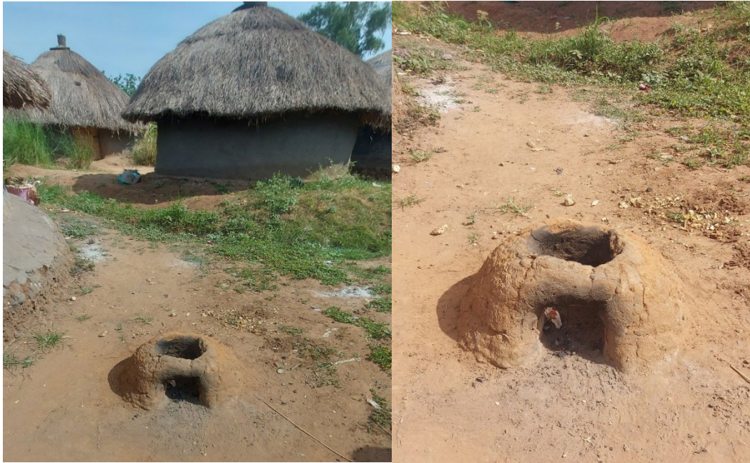
Figura 5.11 Supporto esterno in fango per cucina con legna da ardere
