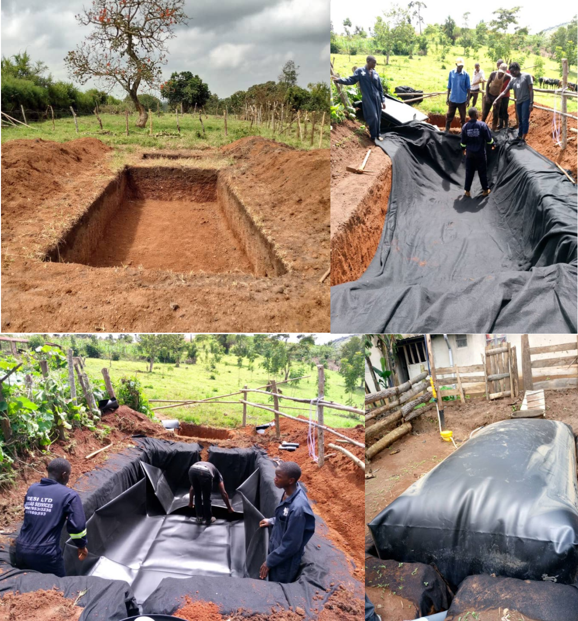
Figura 5.21 Processo di installazione biodigestori in geomembrana
