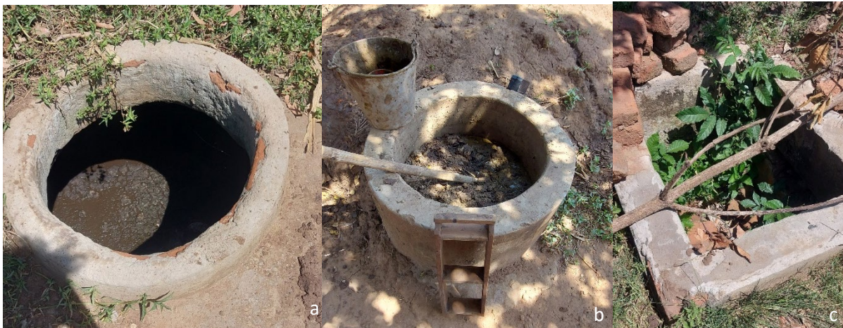
Figura 5.20 Impianto di produzione biogas: a pozzo di immissione, b vasca miscelamento materiale organico acqua, c pozzo prelievo materiale fertilizzante
