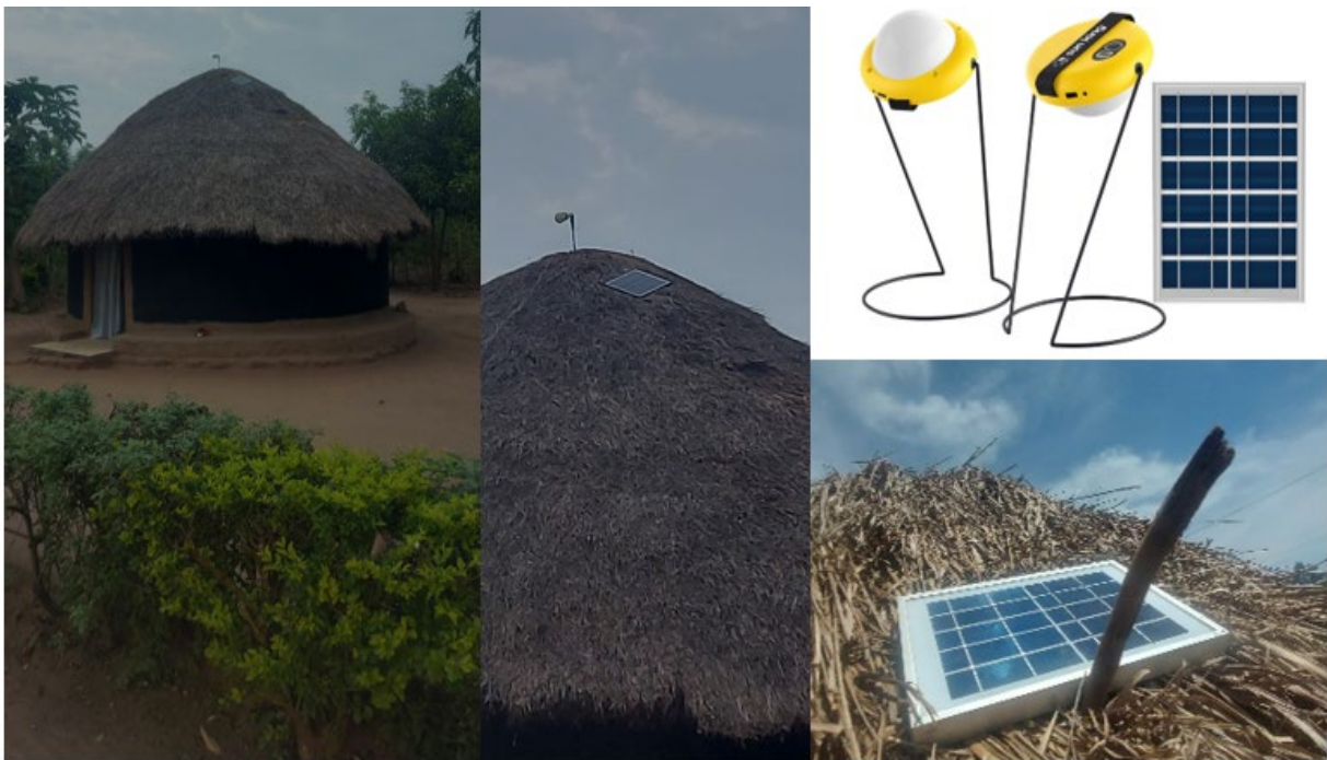
Figura 5.4 Installazione pannello di piccola taglia su tetti di paglia
