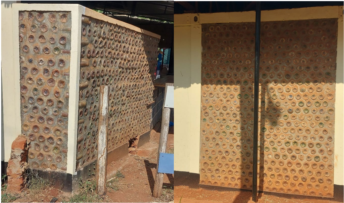
Figura 5.27 Pareti costruite utilizzando bottiglie di plastica riempite di inerti
