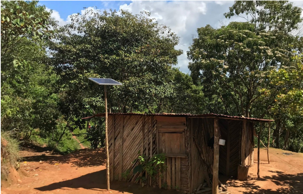
Figura 2.8 Fotografia sistema di approvvigionamento elettricità domestica tramite pannello fotovoltaico (fonte acciona.org)
