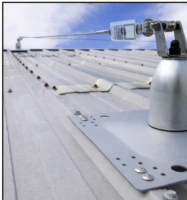
Figura 41: Ancoraggio tipo C
