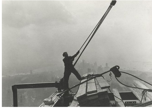
Figura 7-Gestione degli approvvigionamenti in quota durante la costruzione dell'Empire State Building (Piximus)
