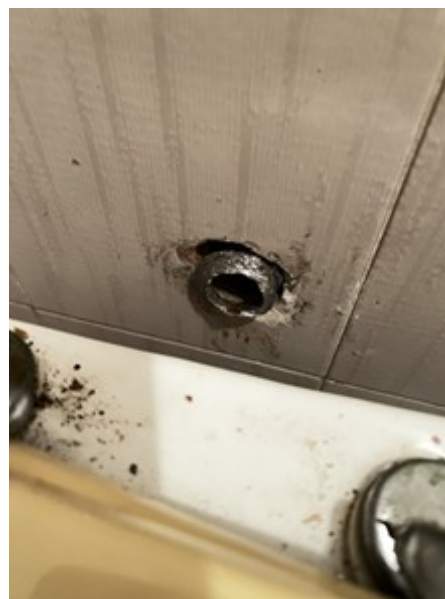
(b) Rottura canotto wc
