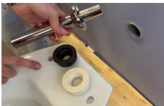
(a) Rottura guarnizione
