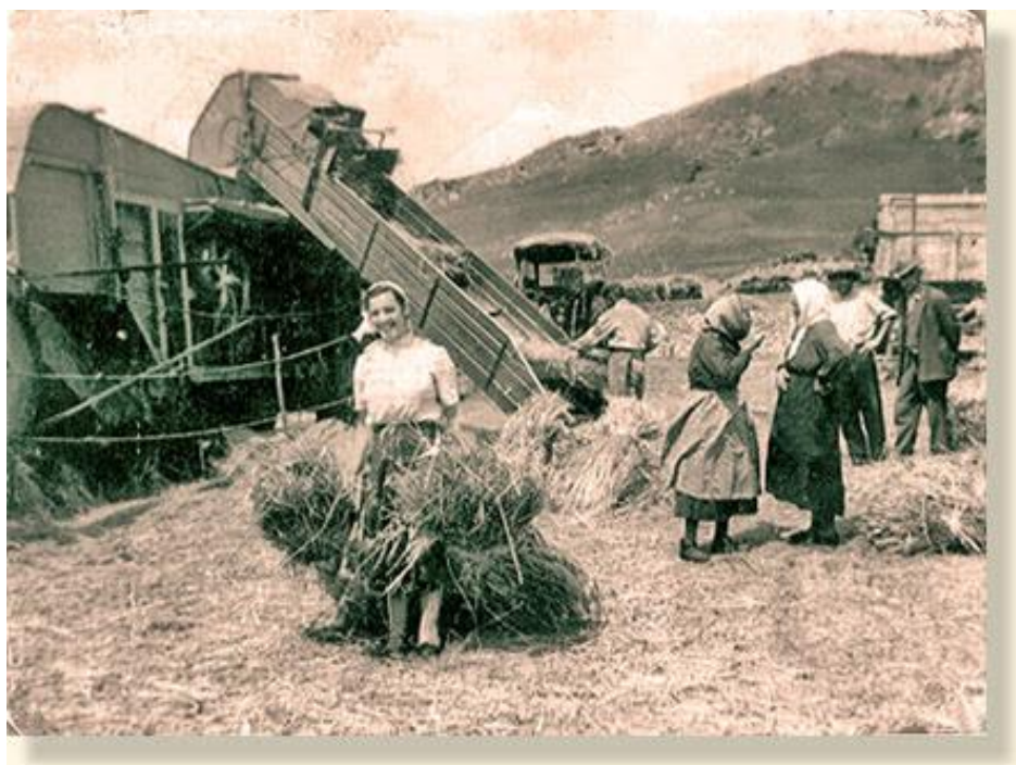
Figura 15: primo sistema di trebbiatura meccanizzata del grano. Il frumento doveva essere sfalciato manualmente e raccolto in fasci per essere trasportato dalla mietitrebbia [45]
