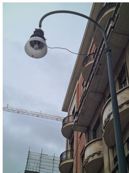
Figura 1.8: Su palo con sbraccio curvo, Torino (Via Verdi)
