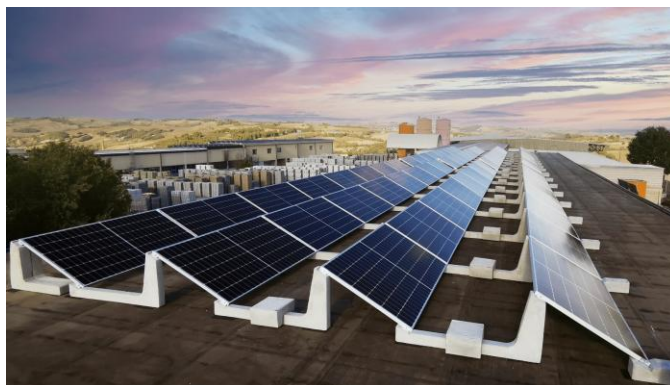
Figura 22 - Zavorre per moduli fotovoltaici su superfici piane
