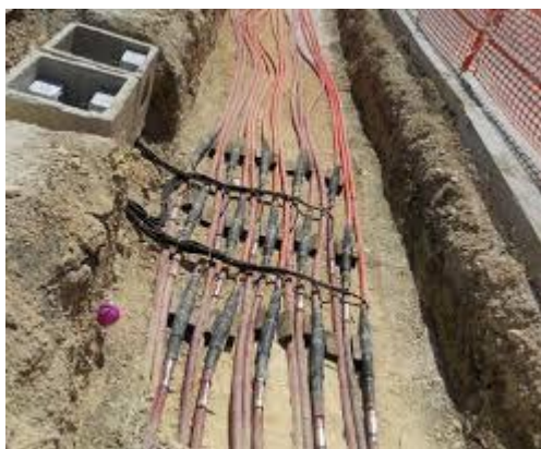
Figura 21 - Cavi interrati (posa 61)
