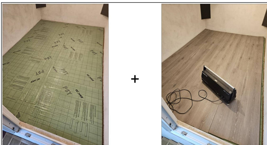
Figura 37 – Solaio con Panel PST + laminato vinilico 12 mm
