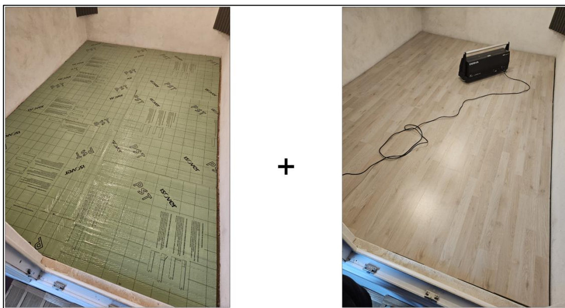
Figura 35 – Solaio con Panel PST + laminato vinilico 6 mm
