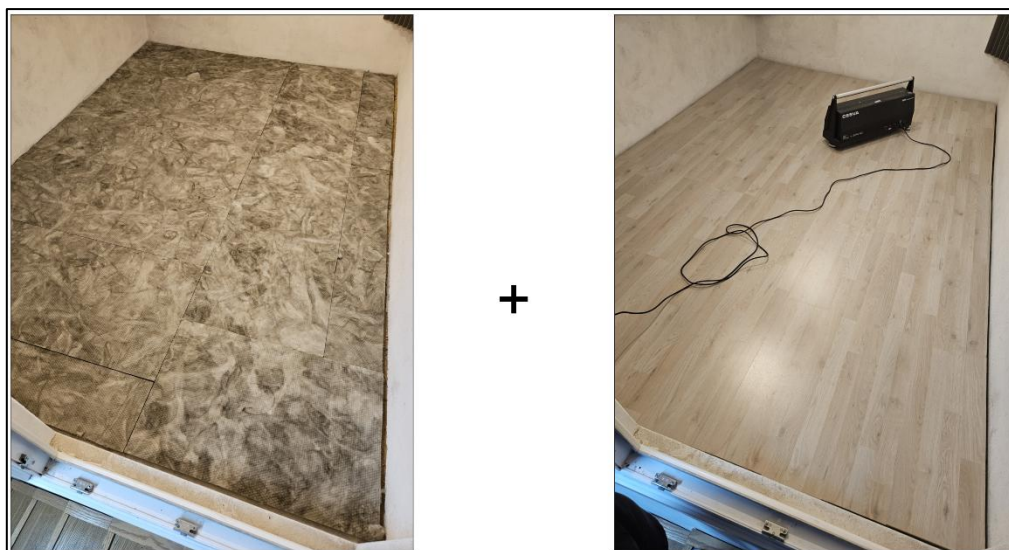
Figura 23 - Solaio con Arena PF - 15 mm + laminato 6 mm
