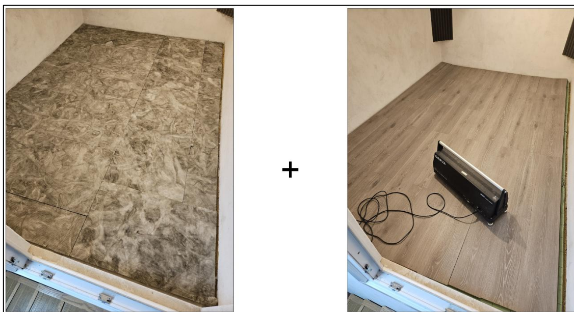
Figura 25 - Solaio con Arena PF - 15 mm + laminato 12 mm
