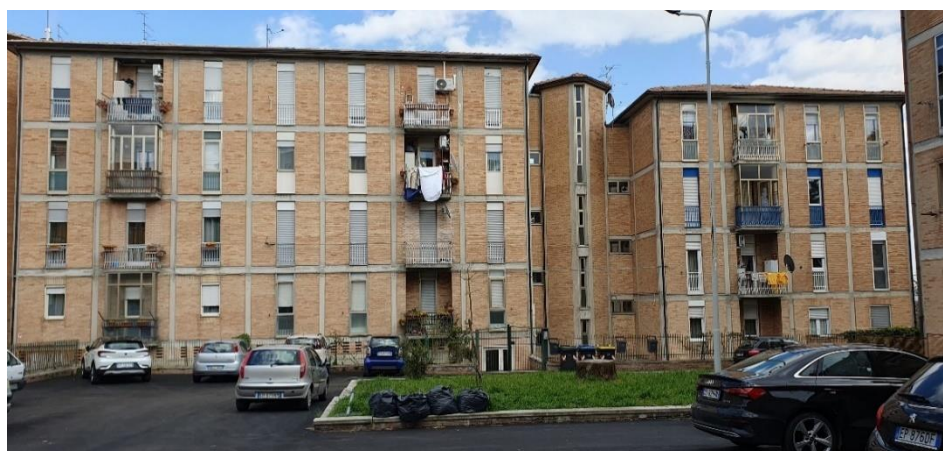
Figura 4.17: Edificio “A”, facciata interno cortile della manica lunga dell’edificio. Fonte: Foto personale scattata Aprile 2023.
