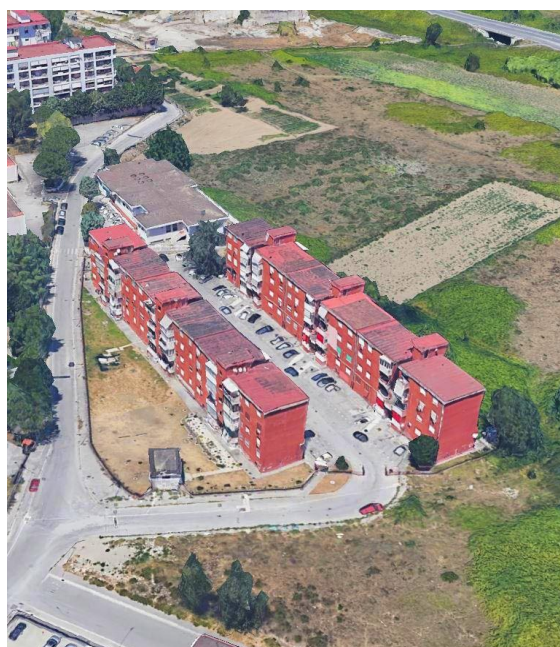
Figura 3.29: Vista dall'alto del complesso.
