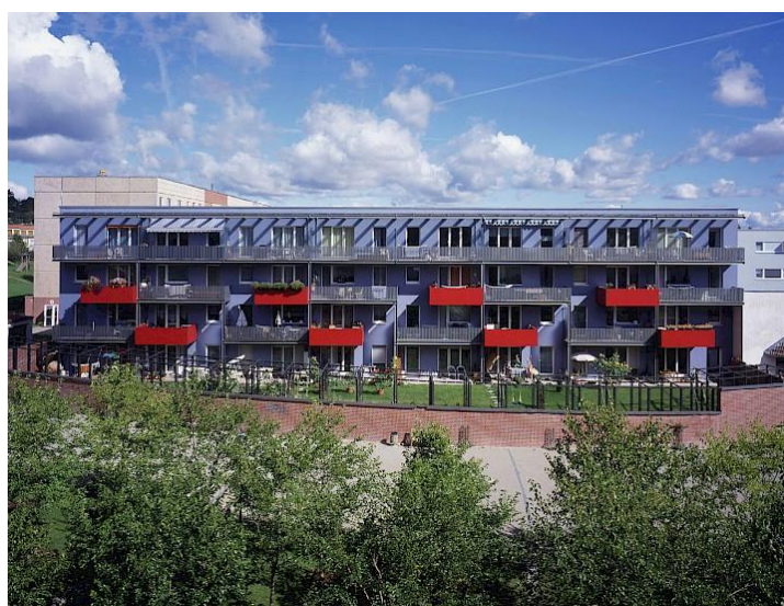
Figura 3.14: Vista del fronte verso il giardino dopo l'intervento.
