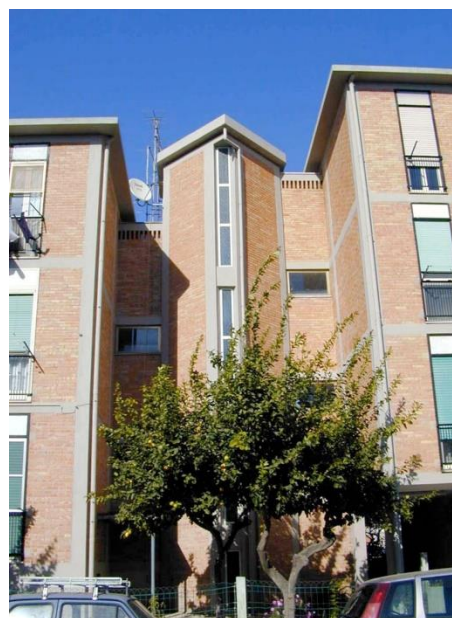
Figura 2.25: Vista vano scale.
