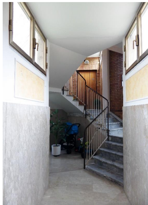
Figura 4.23: Ingresso vano scale.
