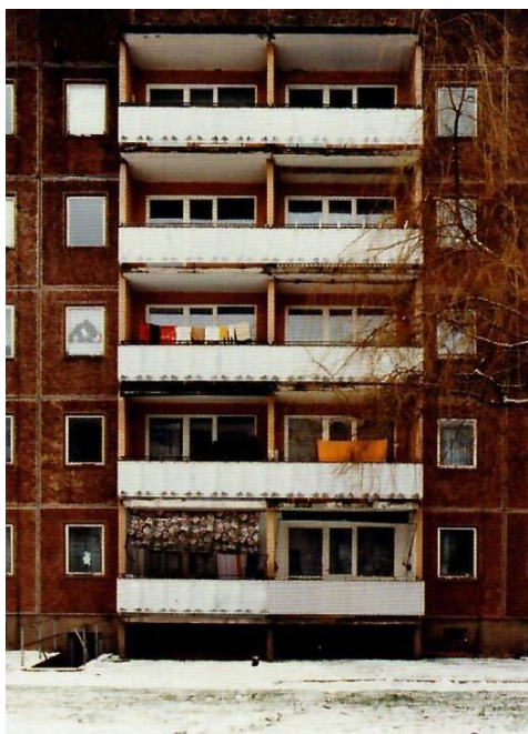
Figura 3.5: Vista dell'edificio prima dell'intervento. Fonte: G. Masera, op. cit. , 2006, p. 37.
