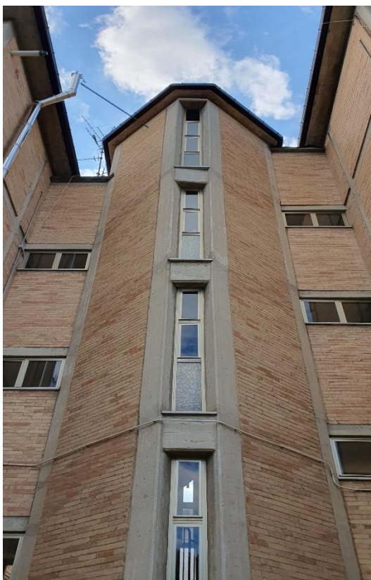
Figura 4.22: Particolare esterno del vano scale. Fonte: Foto personale scattata Aprile 2023.
