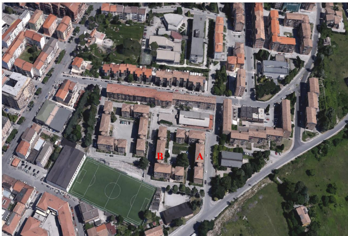
Figura 4.12: Vista satellitare degli edifici. Fonte: Google Earth (Consultato Gennaio 2024).
