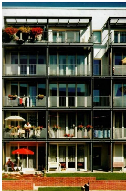
Figura 3.6: Vista dell'edificio finito.
