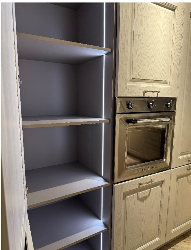
Figura 41: LED incassato sul fianco interno di una colonna ad uso dispensa, Fotografia di produzione propria
