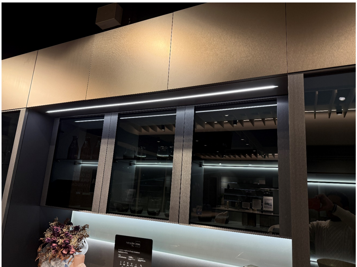
Figura 33: profilo incasso nella mensola portale, Fotografia di produzione propria
