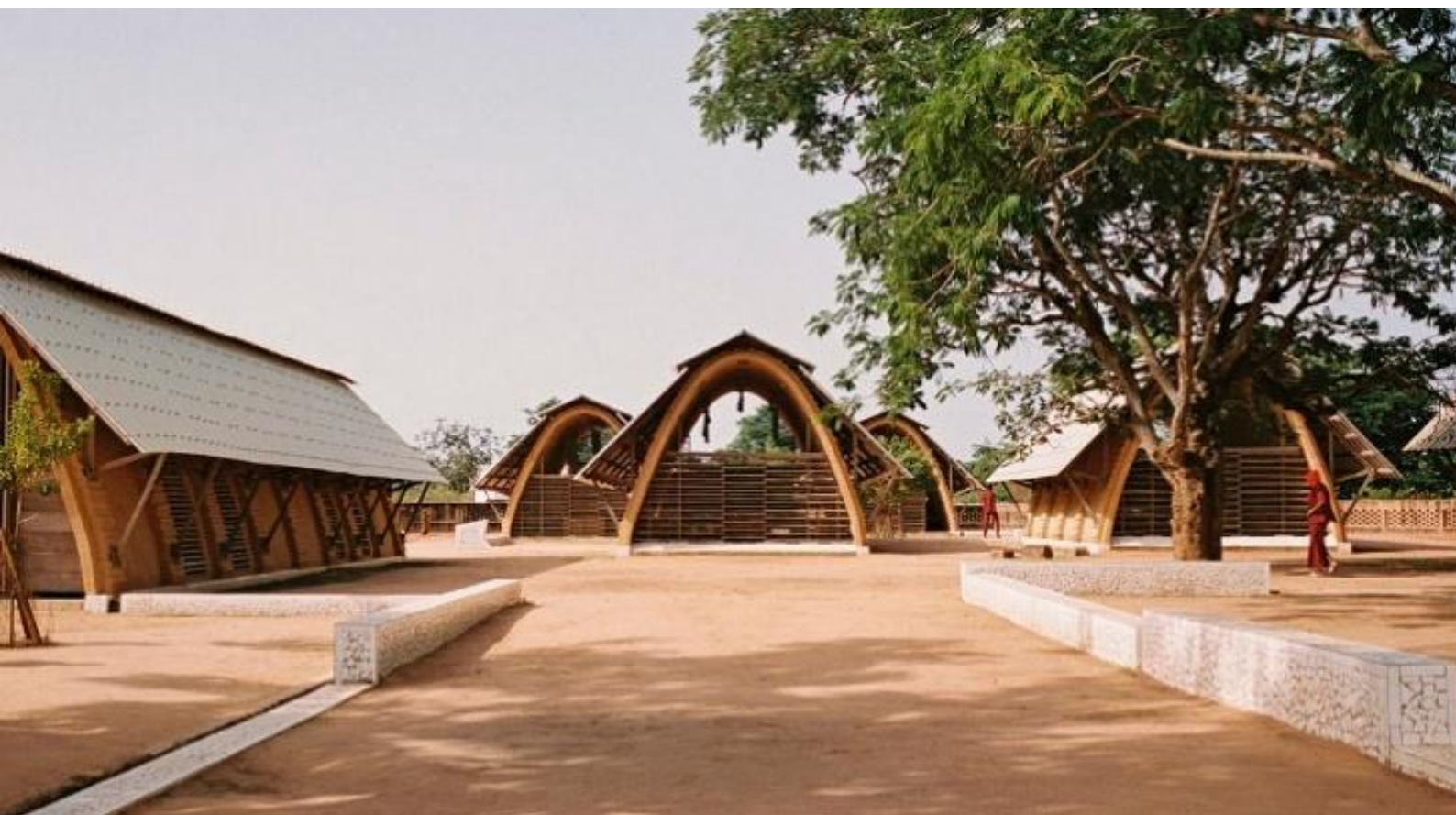
Fig. 1.42 – Kanamar Secondary School, Senegal. Sistema di moduli della scuola secondaria CEM Kanamar (DAWoffice, 2021).
