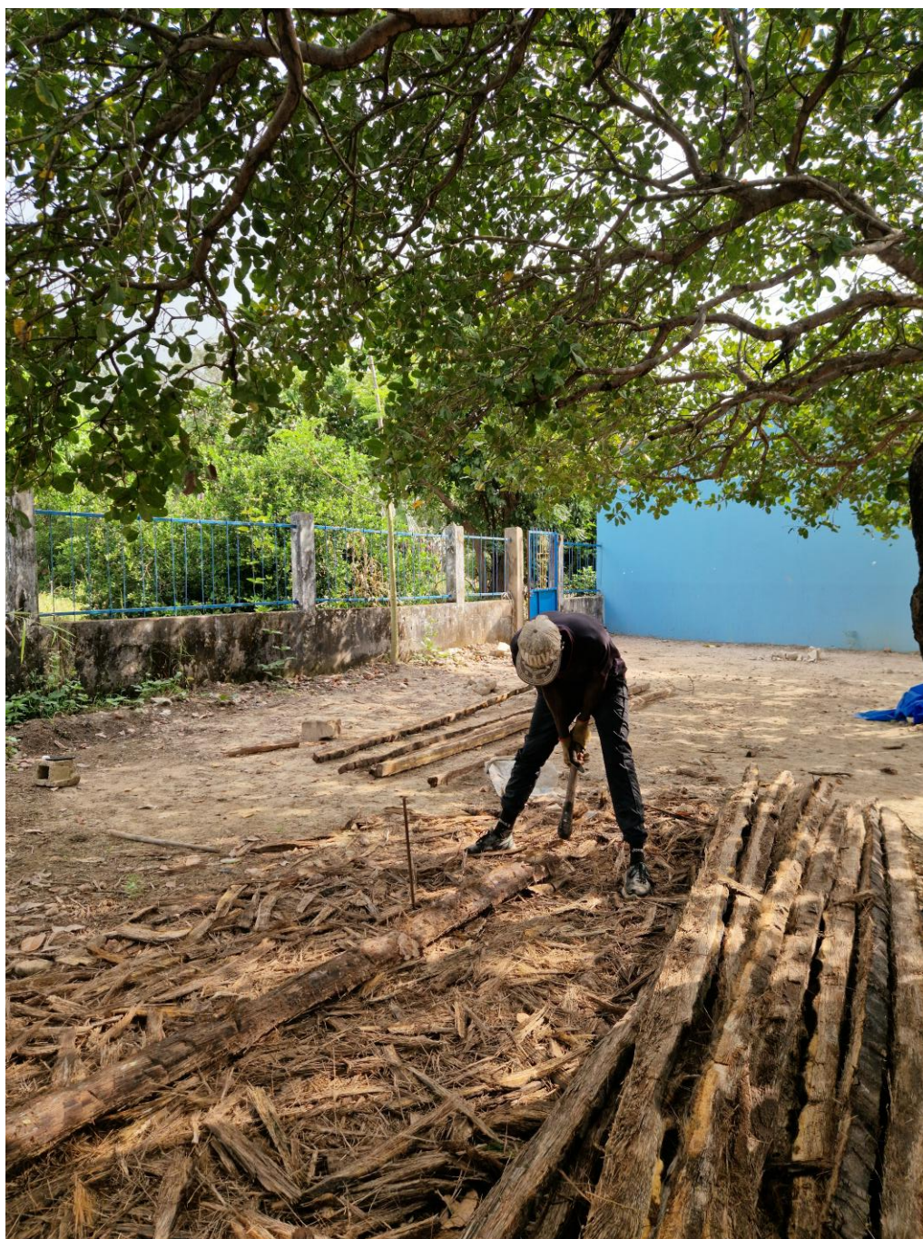
Fig. 5.75 – Il pedrero Mamadu all'opera durante l'affinamento del cibi , Bambadinca (fonte: fotografia dell'autore, ottobre 2025).
