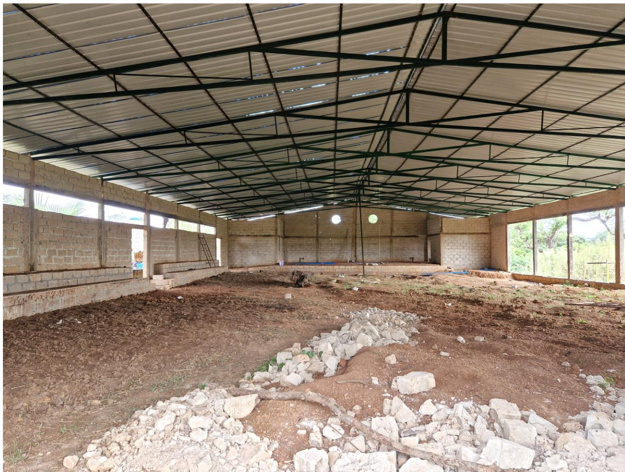
Fig. 5.38 – Centro polisportivo. Interno del centro in fase di cantiere (fotografia dell'autore).
