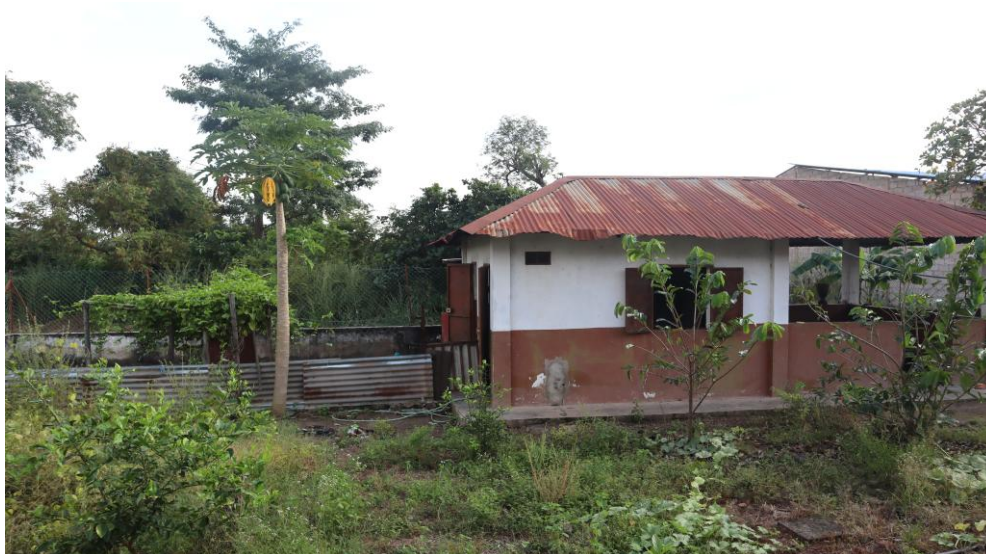
Fig. 5.32 – Stalla. Lato Est con recinto in lamiera per i maiali (fotografia dell'autore).
