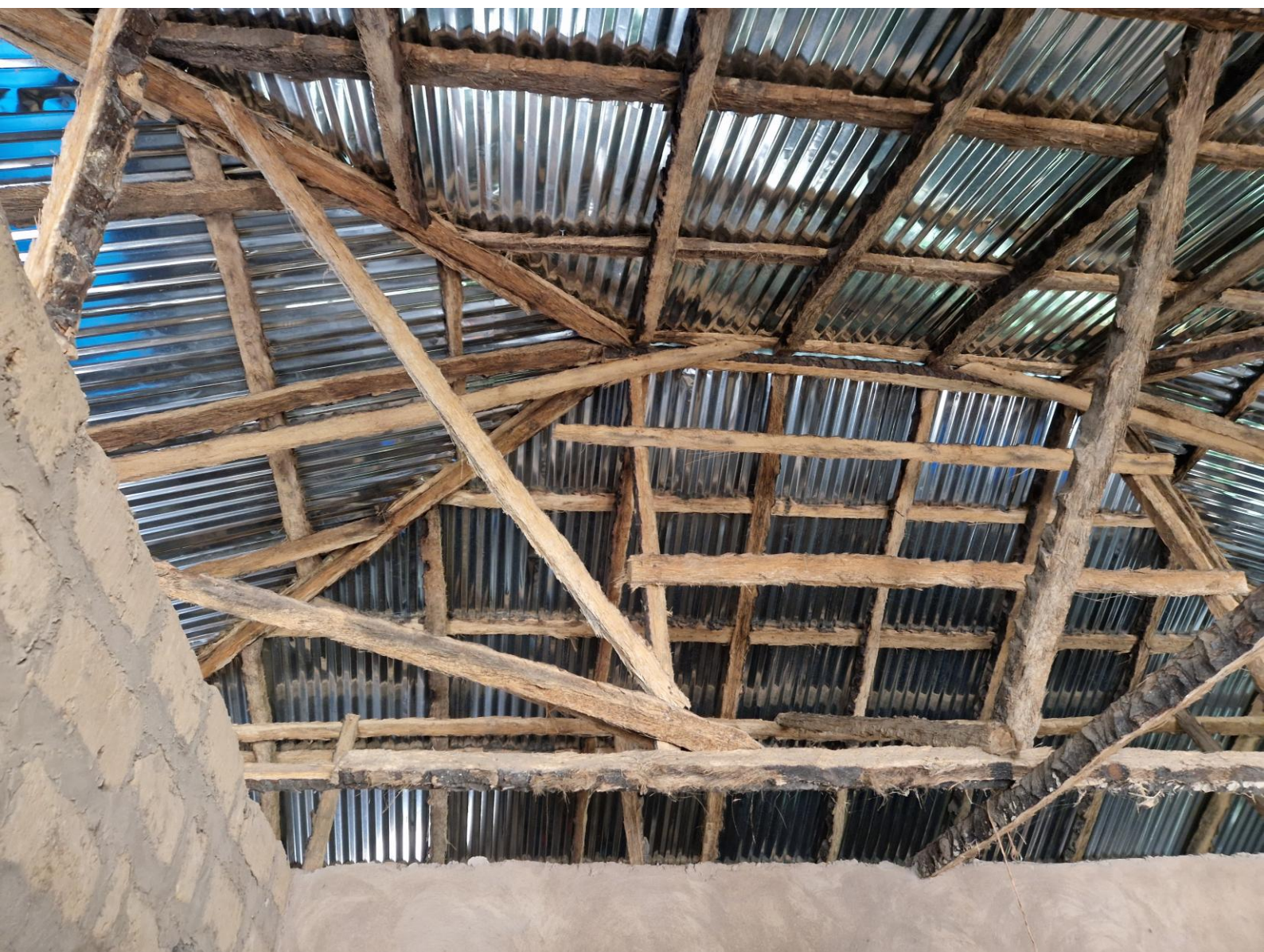
Fig. 5.64 – Struttura di un'abitazione tipica, Bambadinca, Guinea-Bissau (fotografia dell'autore, ottobre 2025).
