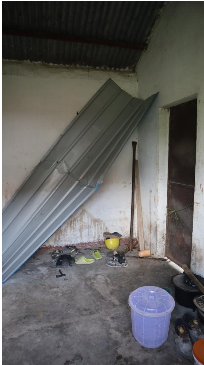
Fig. 5.34 – Stalla. Deposito attrezzi (fotografia dell'autore).
