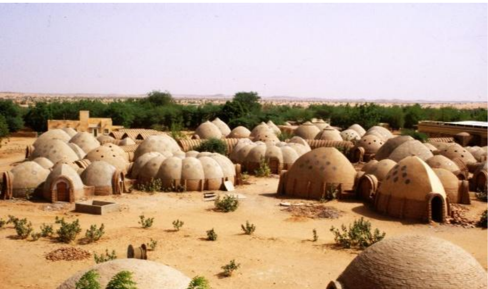
Fig. 1.26 – Ospedale Regionale, Mauritania. Il nosocomio progettato da Fabrizio Carola caratterizzato dalle cupole a doppia calotta (fonte: L. ALINI, 2016, p. 25).
