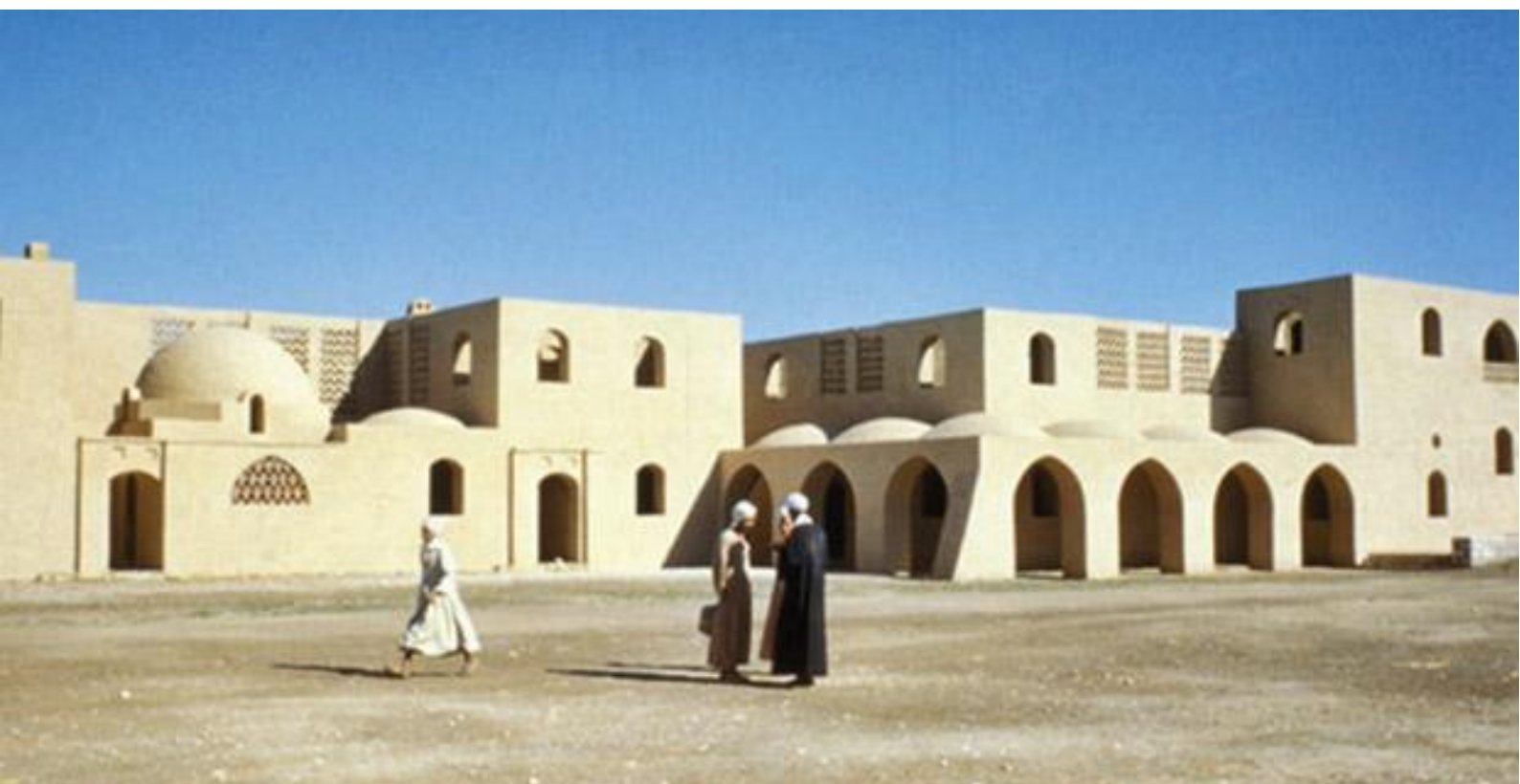
Fig. 1.11 – New Gournà Village, Egitto. Architettura in argilla per la comunità (fonte: Architettura della terra: Hassan Fathy e l'esperimento di New Gournà ).
