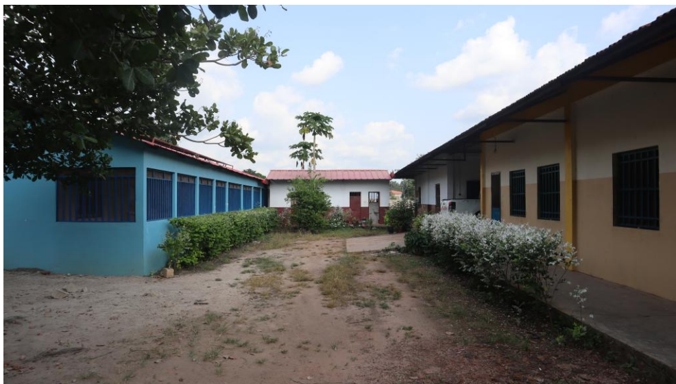
Fig. 5.23 – Blocco servizi. Cortile chiuso dal blocco servizi (fotografia dell'autore).
