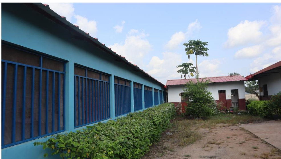
Fig. 5.19 – Dormitorio. Veranda in affaccio sul cortile (fotografia dell'autore).
