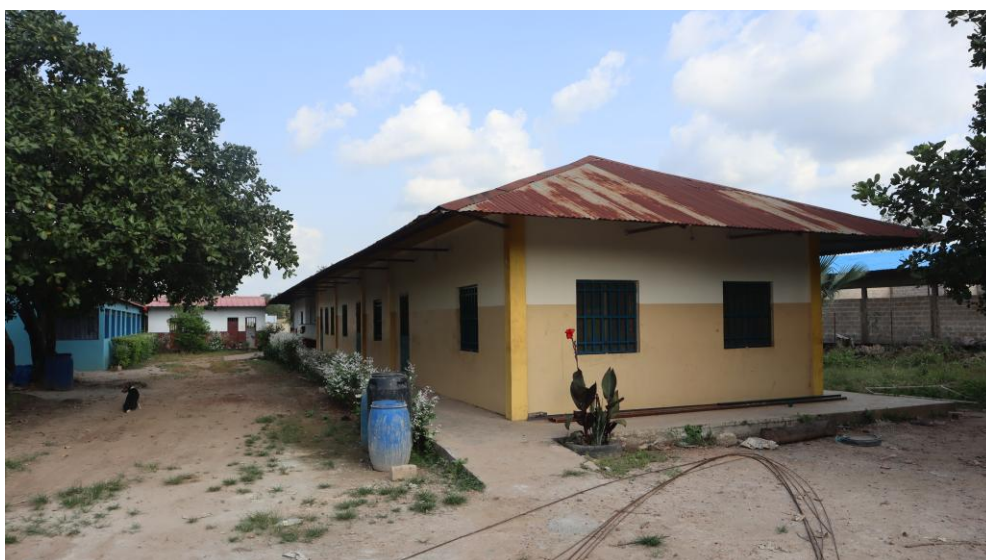
Fig. 5.14 – Manica formativa. Vista dall'ingresso del centro formativo (fotografia dell'autore).
