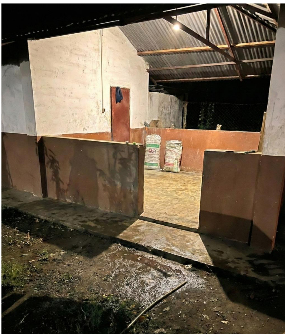
Fig. 5.33 – Stalla. Vista notturna dell'ingresso del deposito (fotografia dell'autore).
