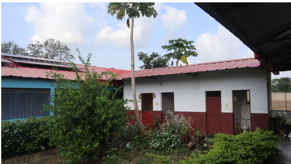
Fig. 5.25 – Dormitorio. Struttura che connette il dormitorio alla manica formativa (fotografia dell'autore).
