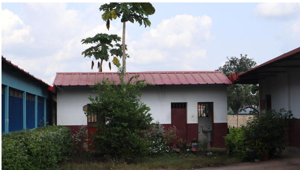
Fig. 5.24 – Blocco servizi. Prospetto principale (fotografia dell'autore).
