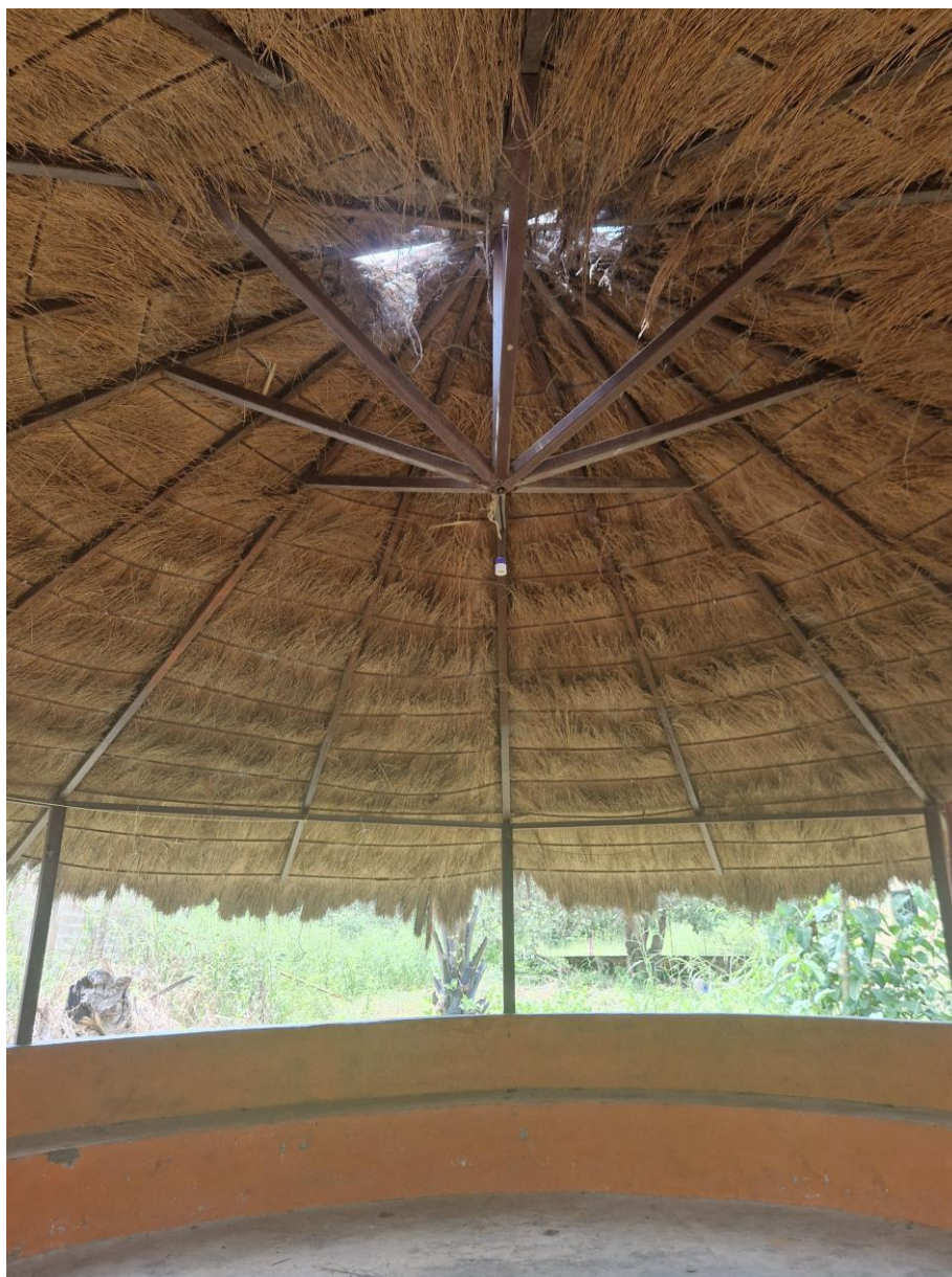
Fig. 5.30 – Capanna circolare esterna. Struttura interna metallica di sostegno per la copertura in paglia (fotografia dell'autore).
