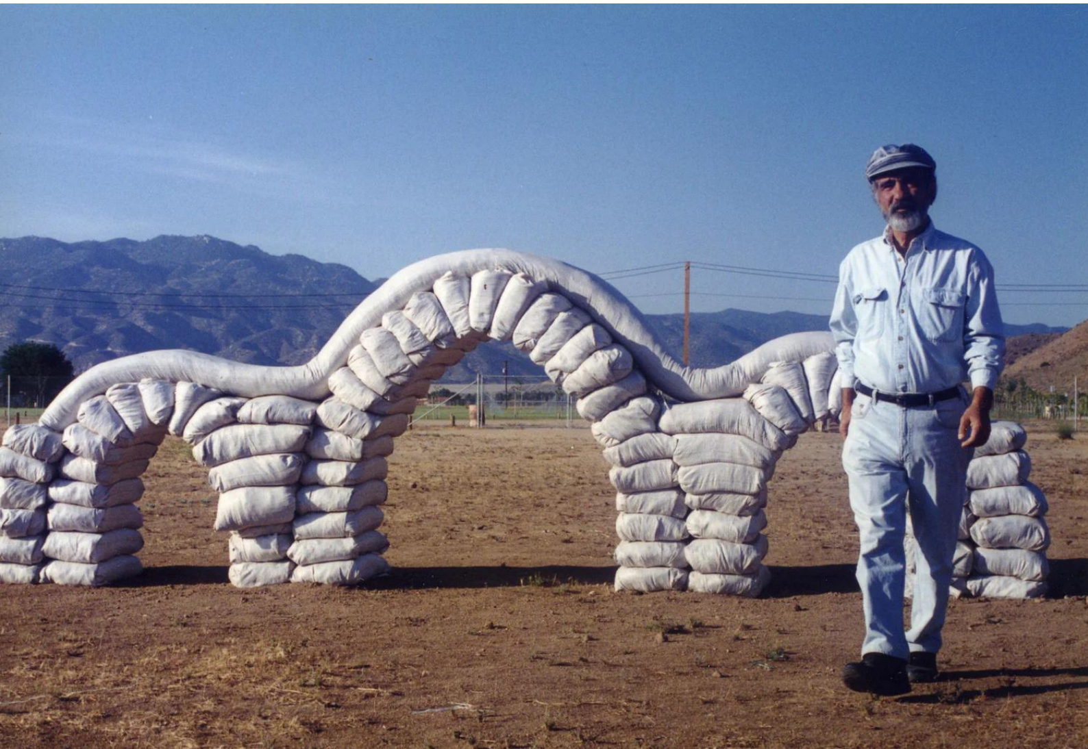
Fig. 5.71 – Nader Khalili e il sistema costruttivo del SuperAdobe (fonte: CalHeart).
