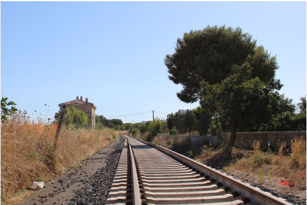
Figura 1.21 Linea Noto-Pachino in fase di ripristino: fermata Falconara Iblea, luglio 2025. Fonte: Fotografia delle autrici.
