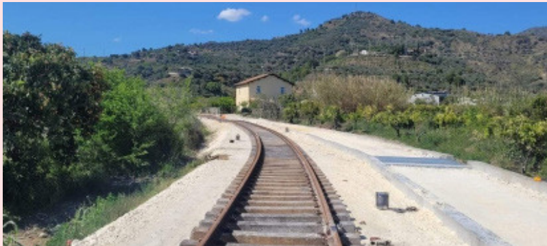
Figura 2.35 Lavori di ripristino lungo la linea Alcantara-Randazzo, 2023.
