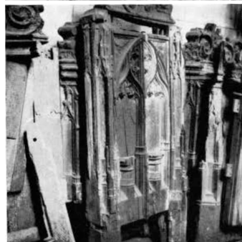
58. Fotografie di cantiere che mostrano l'utilizzo della nuova pietra in relazione agli elementi originari ritrovati e catalogati
