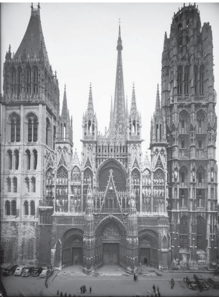
46. Facciata ovest della cattedrale di Rouen.
