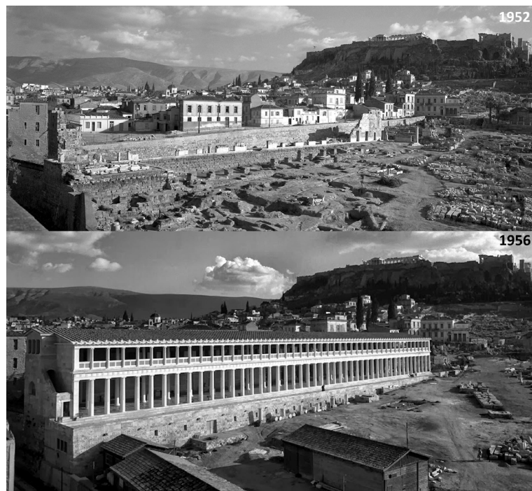
31. Fotografia del portico di Attalo “prima e dopo” della ricostruzione.
