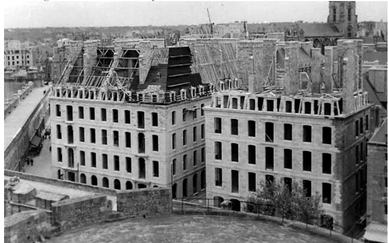
40. Fotografia di Saint-Malo in fase di ricostruzione
