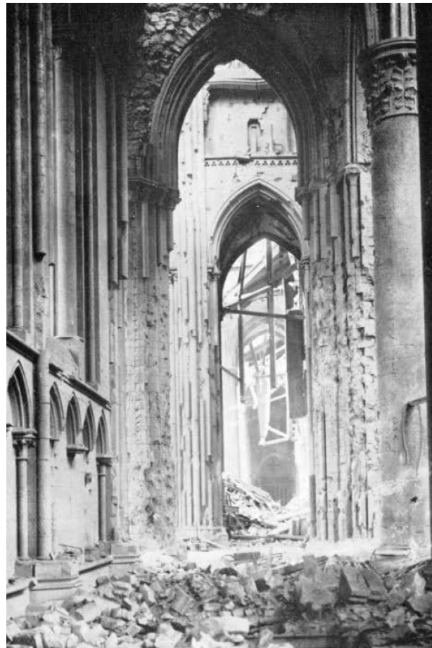
55. Danni all'interno della cattedrale
