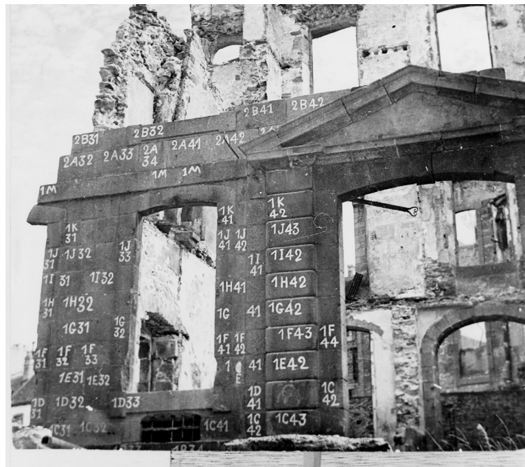
41. Fotografia della numerazione delle pietre di una delle facciate di Saint-Malo.
