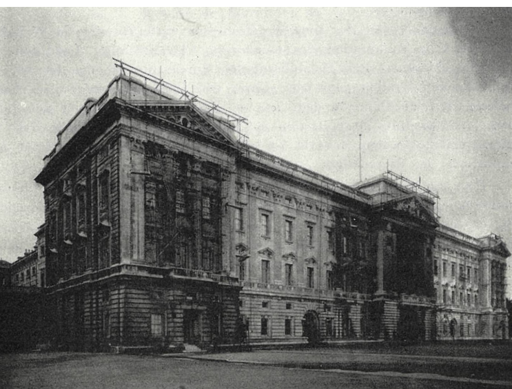
27. Fotografia di Buckingham Palace durante i lavori di restauro della facciata, Londra.
