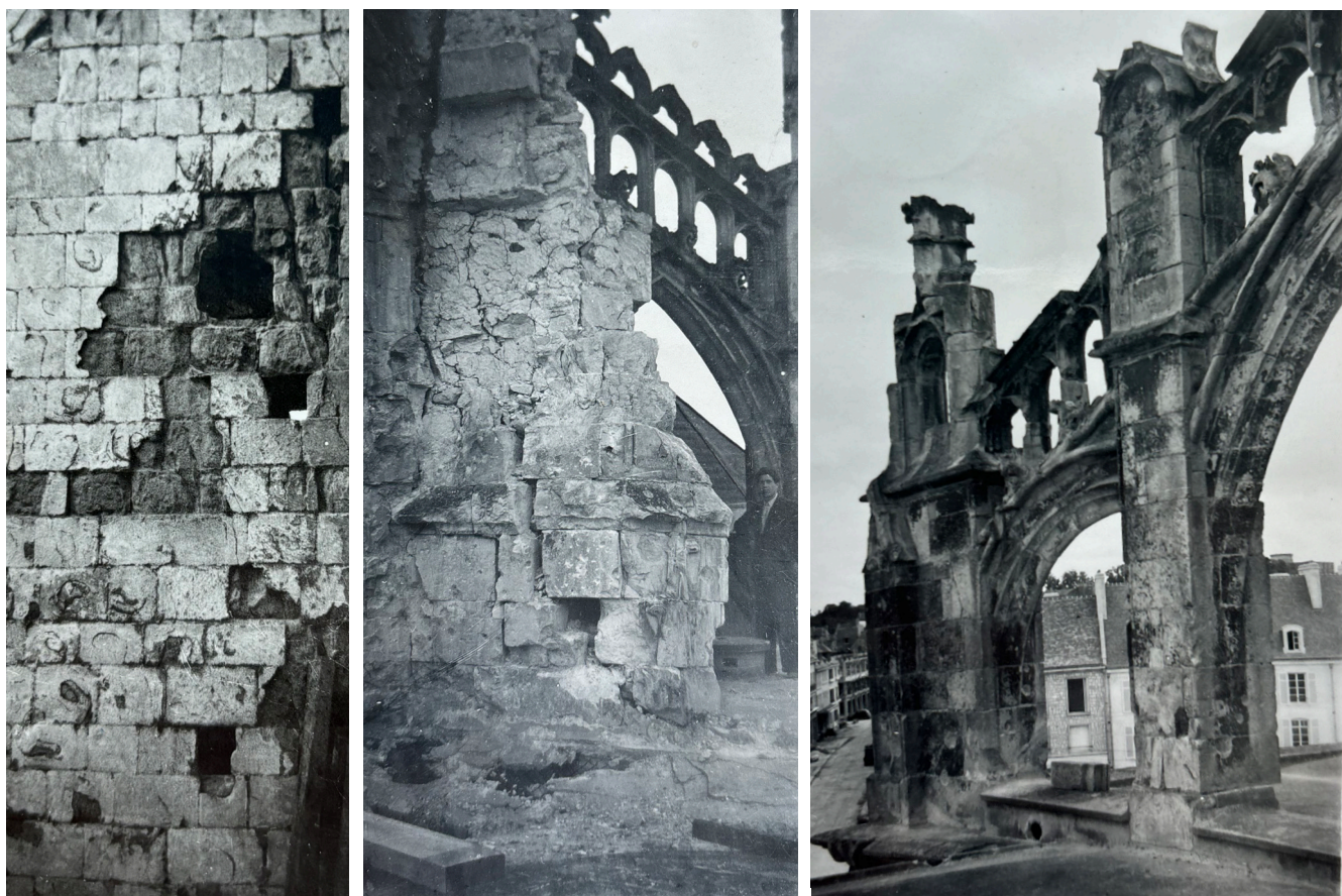
82. Fotografie dei dommages de guerre , a sinistra i paramenti interni del clocher, a destra i danni agli arc-boutants .
