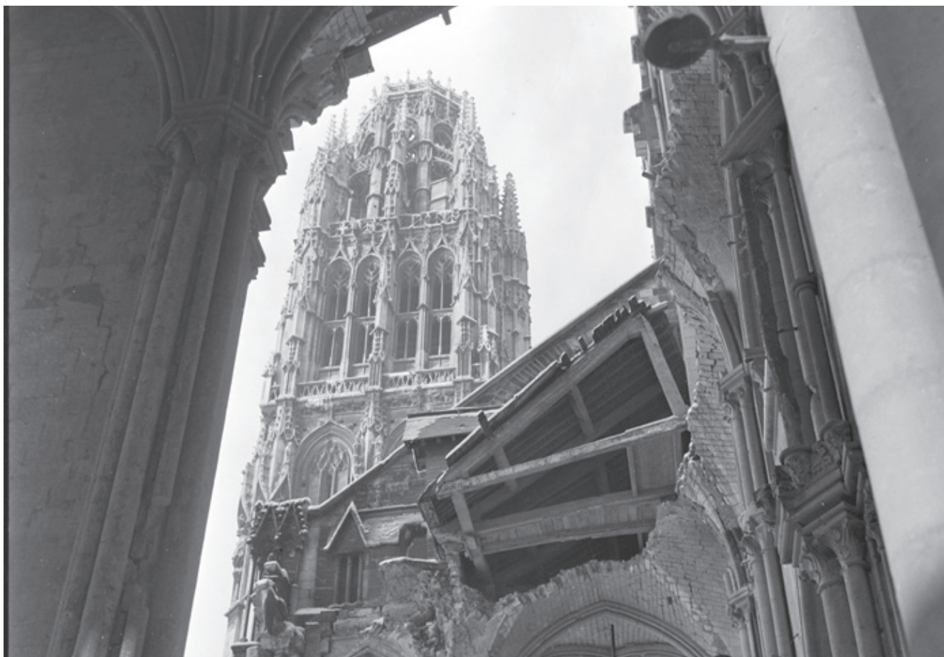
53. Le coperture e sistemi voltati distrutti della bas-côté sud
