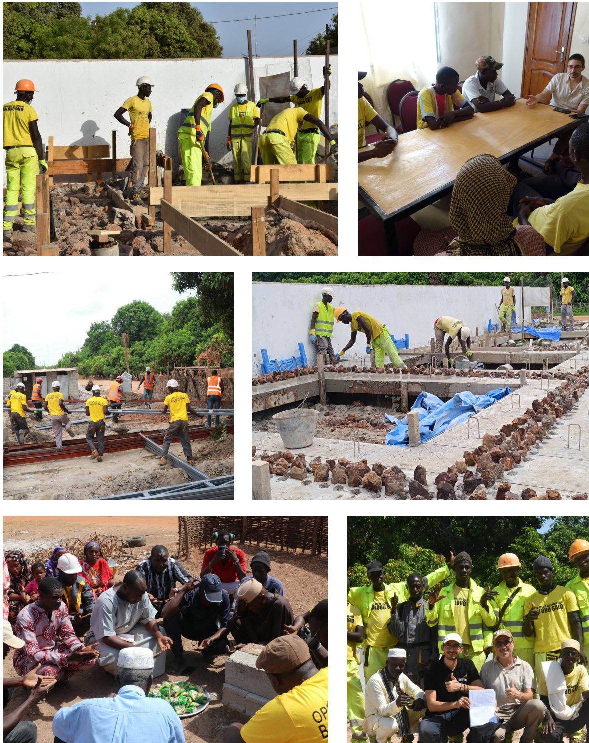
Figura 33., 34., 35., 36., 37., 38. Operai in cantiere/ Fondatore di Balouo Salo in riunione/ Lavori sul cantiere/ Fondazioni con pietrame irregolare/ Pranzo della comunità/ Operai insieme al fondatore dell'associazione
