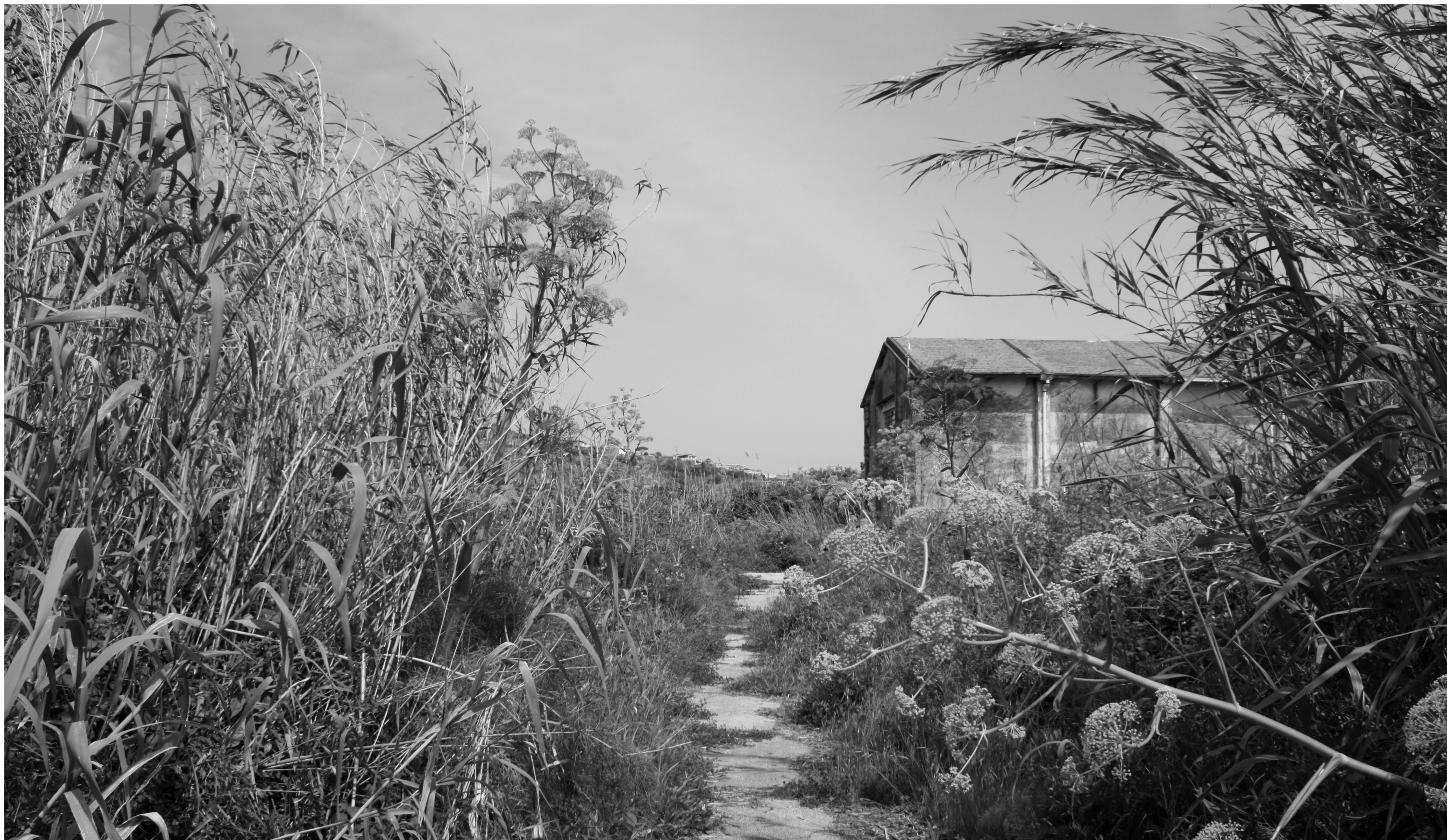
Foto 4 - Fronte laterale di un capannone dal sentiero interno al complesso
