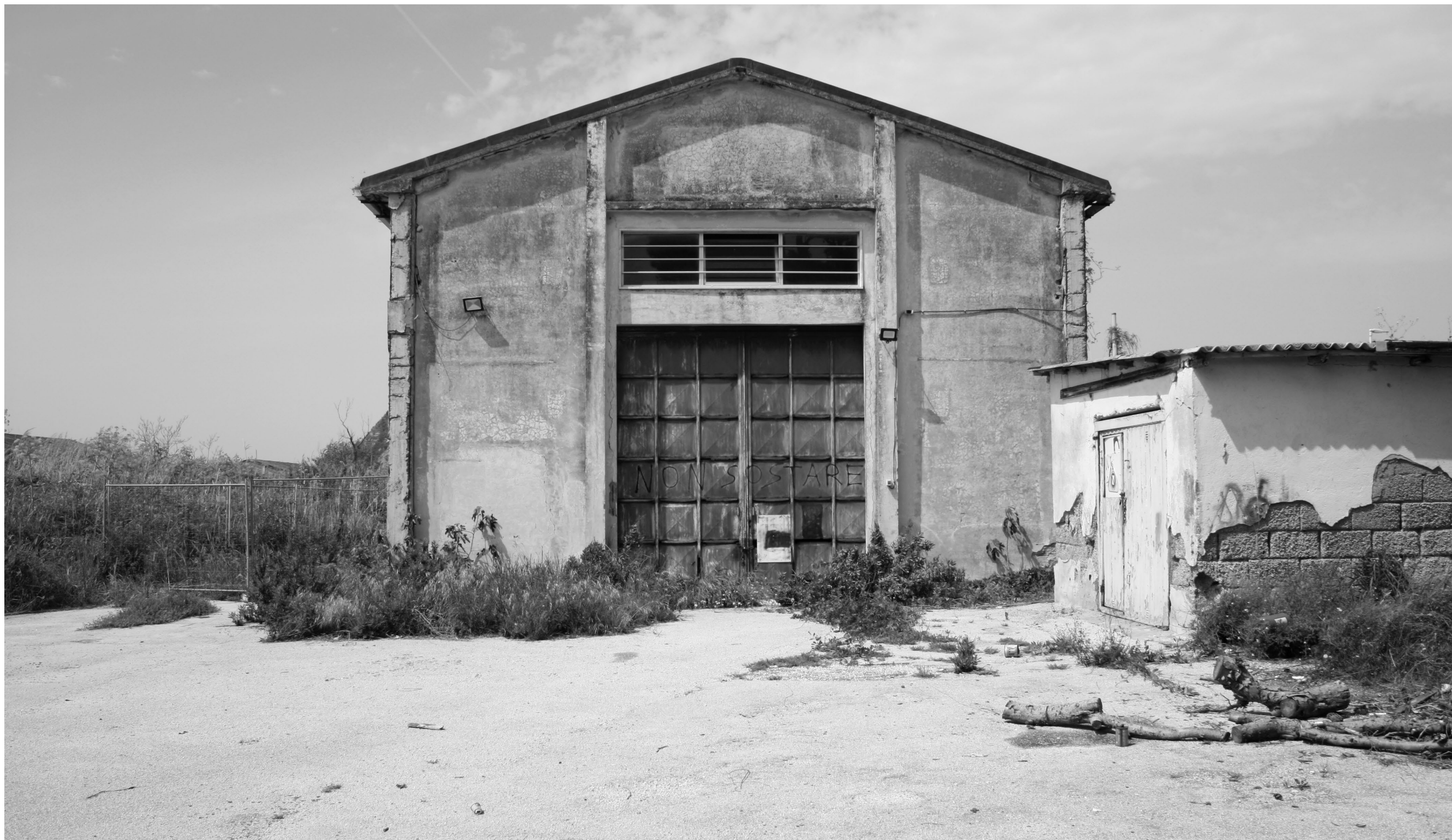
Foto 5 - Fronte del capannone d'ingresso
