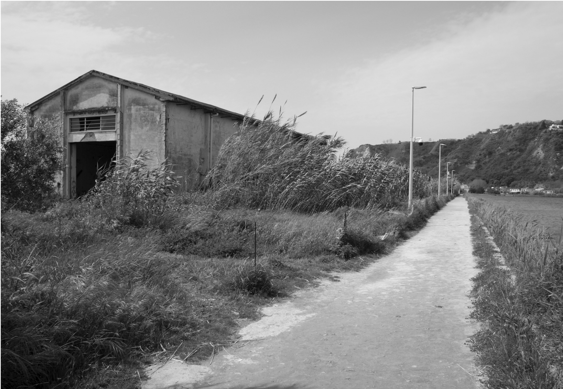
Foto 10 - Vista laterale dei capannoni dal sentiero lungolago
