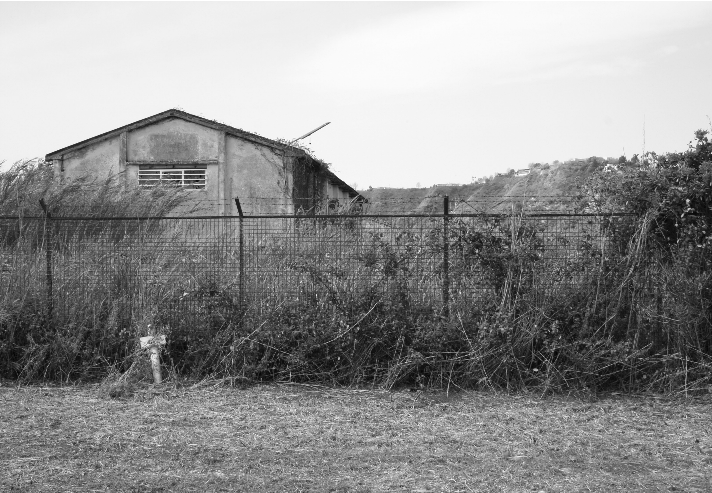
Foto 6 - Scatto dall'esterno del complesso: il perimetro est con recinzione metallica
