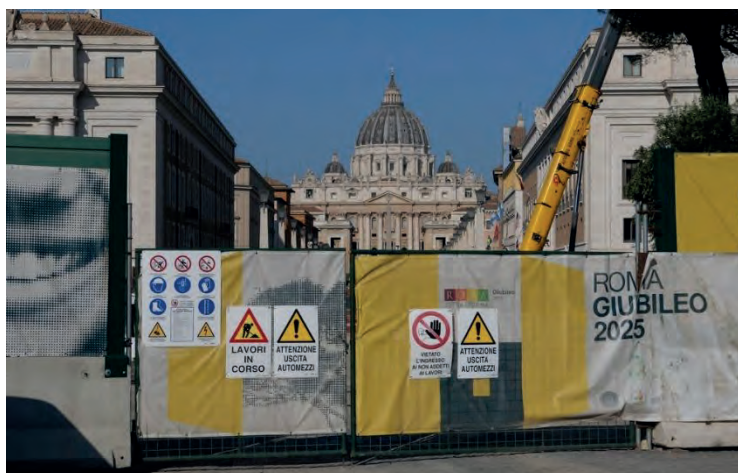
Figura 16 - Cantiere in corso interventi Giubileo 2025 Roma . Fonte: consulesi.it
