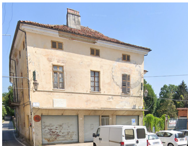
Fig. 15. Facciata di palazzo Mautino su via Principe Tommaso, stato attuale.
