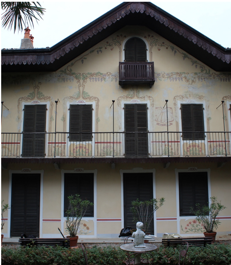
Villa il Meleto ad Agliè, facciata principale.
