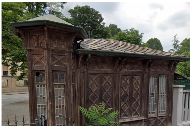
Fig. 58. Capanno ligneo in via Villa alla Quiete Torino
