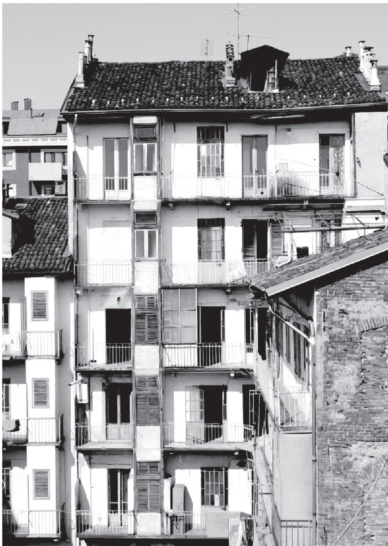
▼ Fig. 129 Zoom del prospetto interno cortile dell'edificio del progetto Giulio34. Fonte: Scatti elaborati con il drone durante il workshop di falegnameria.
