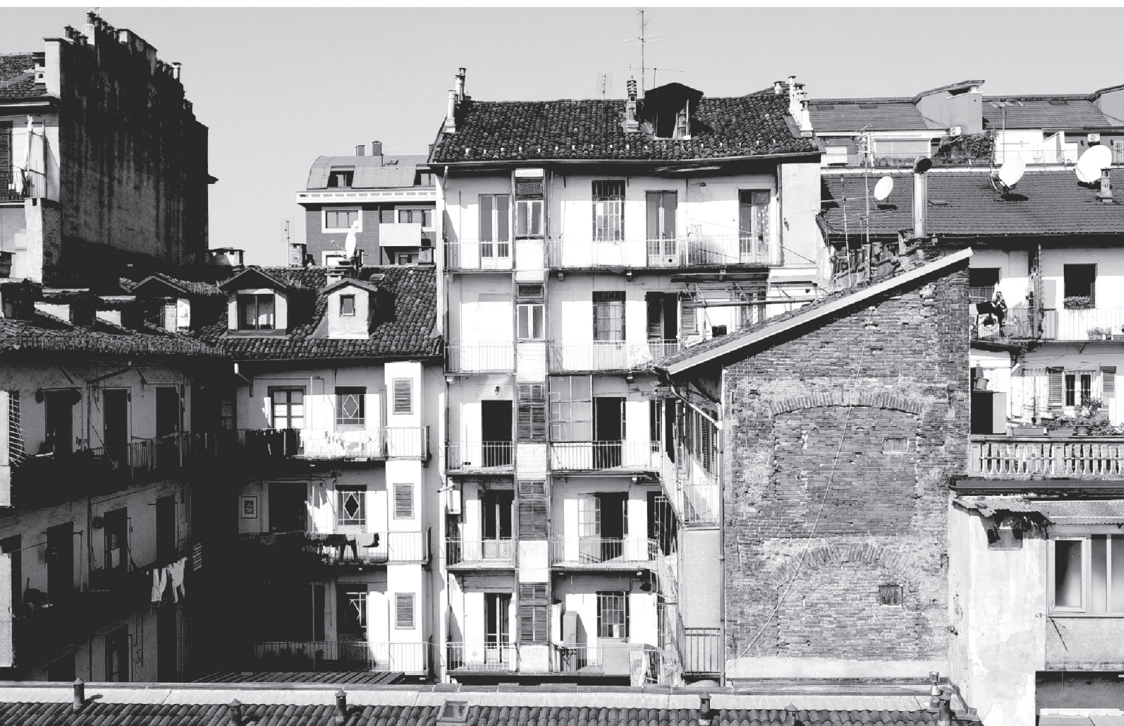
▼ Fig. 107 Prospetto interno cortile dell'edificio del progetto Giulio34. Fonte: Scatti elaborati con il drone durante il workshop di falegnameria.
