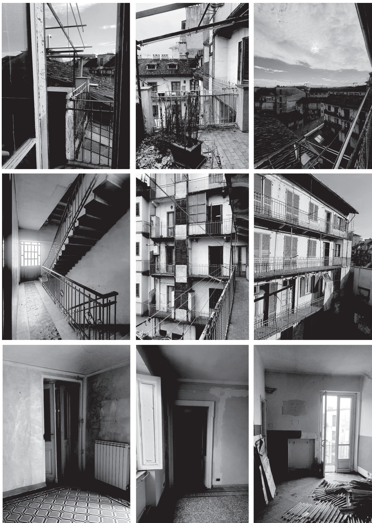
▼ Fig. 135 Scatti dello stato di fatto dell'immobile. In ordine: gli spazi esterni e la vista; le scale interne e i ballatoi; gli interni degli appartamenti. Immagini della Presentazione del CLT. Fonte: https://www.fondazioneportapalazzo.org/
