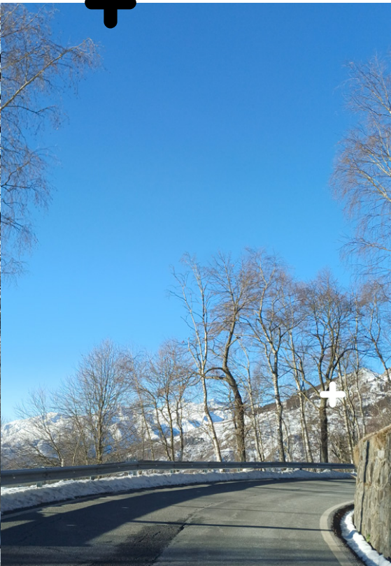
Fig. 15 Vista della Strada Panoramica Zegna, dicembre 2025, fotografie personali.
