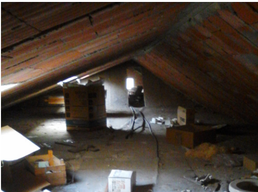
Fig. 135 Ex IPAI, interni del fabbricato, Area Tecnica Provincia di Biella, 2025.
