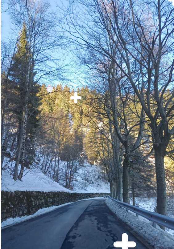
Fig. 16 Vista della Strada Panoramica Zegna, dicembre 2025, fotografie personali.
