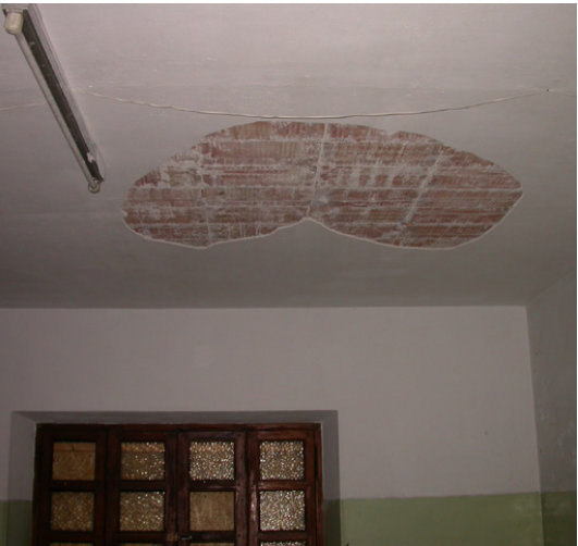
Fig. 133 Ex IPAI, interni del fabbricato, Area Tecnica Provincia di Biella, 2025.
