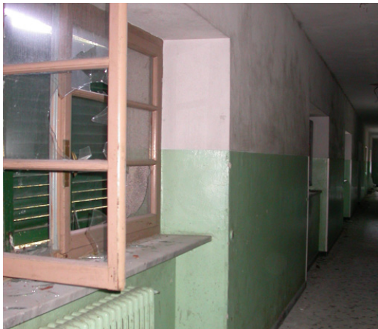
Fig. 134 Ex IPAI, interni del fabbricato, Area Tecnica Provincia di Biella, 2025.
