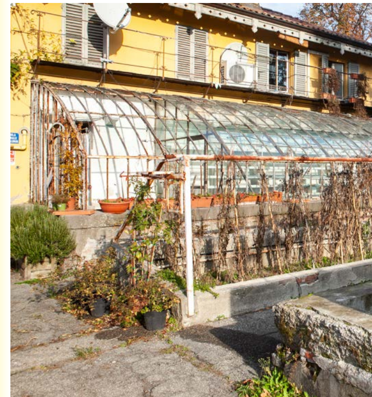
↓ Le Serre prima dei lavori di rigenerazione
