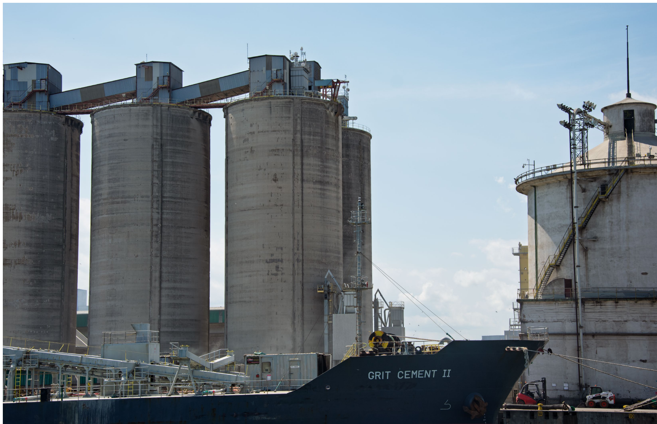
↑ I silos di SuperBeton S.p.A. a Porto Marghera.
