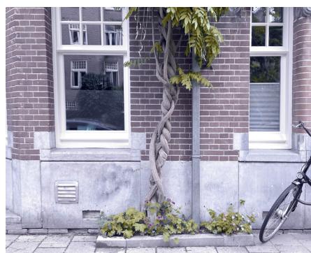
Fig.11 Attacco a terra della facciata vegetata con Wisteria sinensis , Saxen-Weimarlaan 20, Amsterdam
