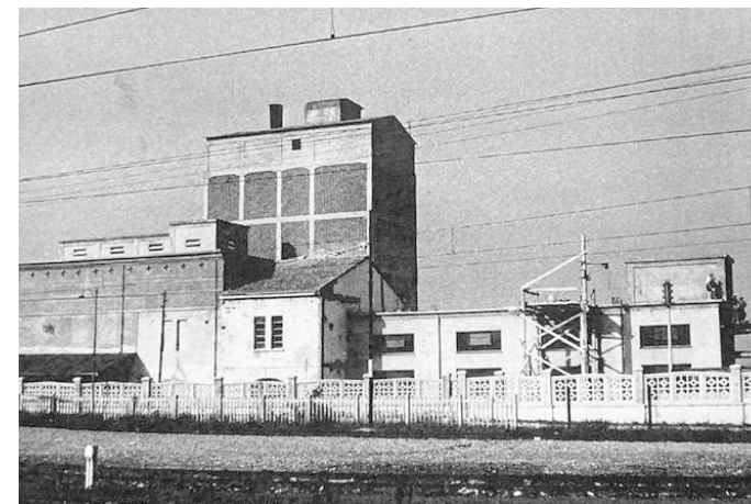
Fig.22 - 1955 - foto lato sud, completamento dello spazio per ospitare il molino rotante orizzontale Breda
