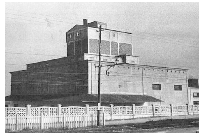
Fig.24 - 1956 - foto lato sud ovest, completa sostituzione della storica casa originale con strutture in cemento armato
