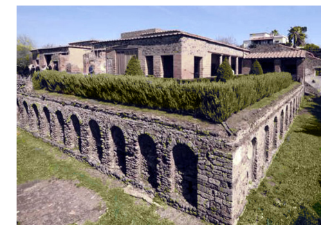
Fig.2 Copertura vegetata, Villa dei Misteri, Pompei
