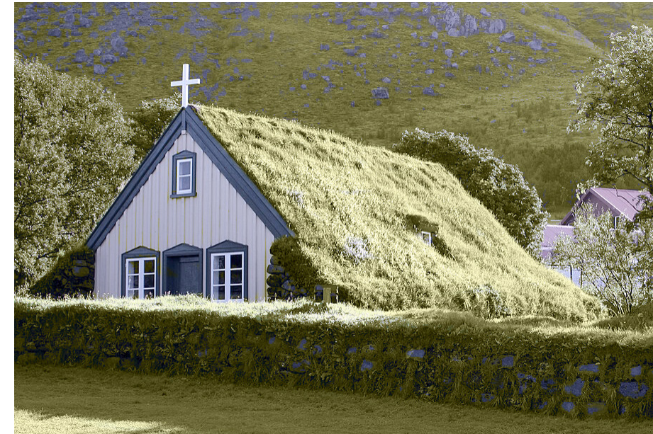
Fig.1 Tradizionale struttura a turf house costruita nel 1883-85 in Islanda
