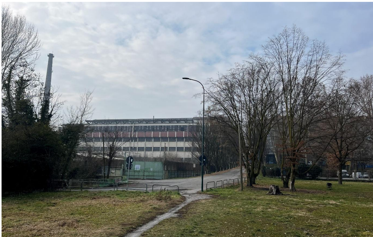
25. Vista del retro della Manifattura da ovest, dal Parco della Confluenza, 2025.
