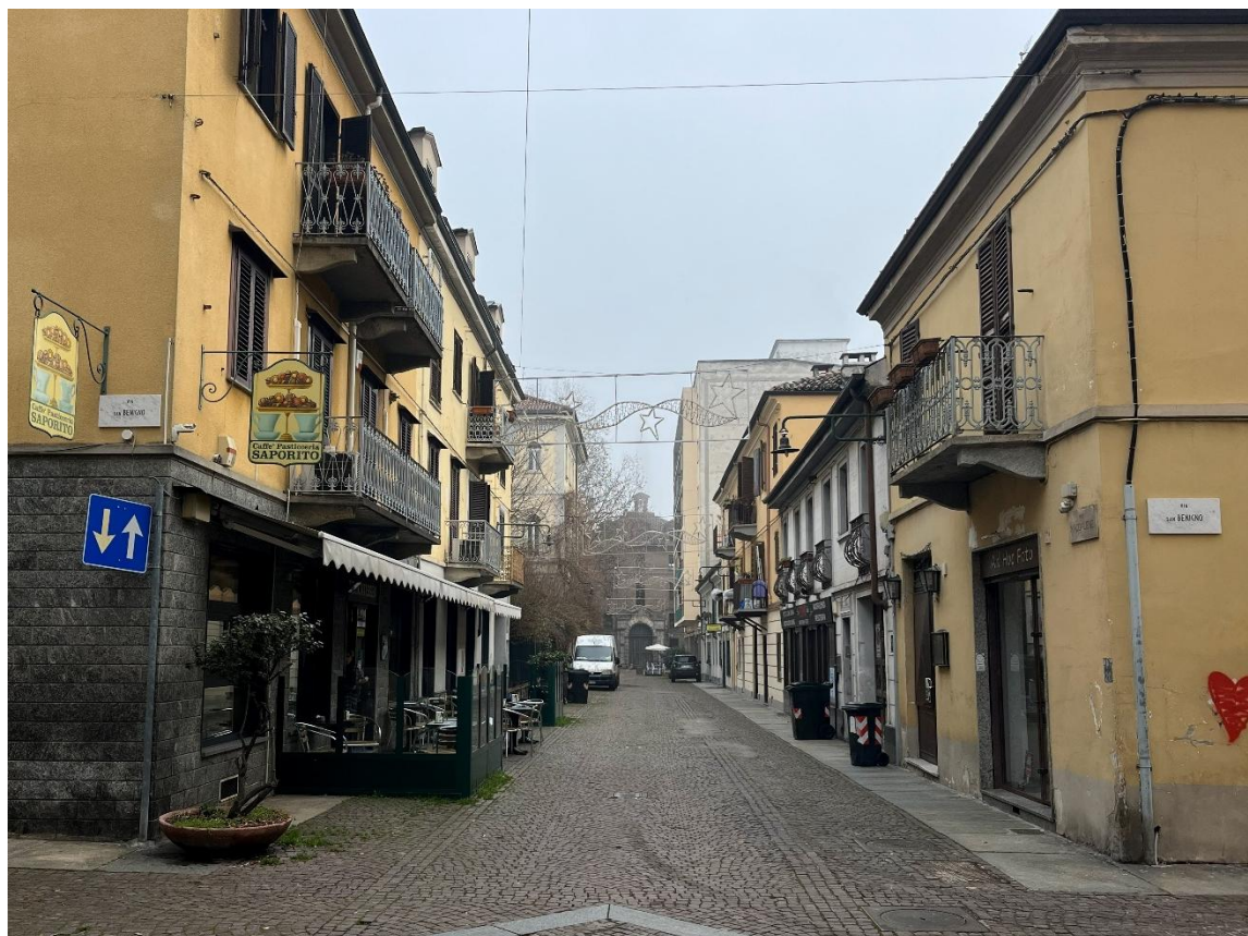
30. Relazione tra il borgo, caratterizzato da case basse e la Manifattura. Vista da Via Maddalene, 2025.
