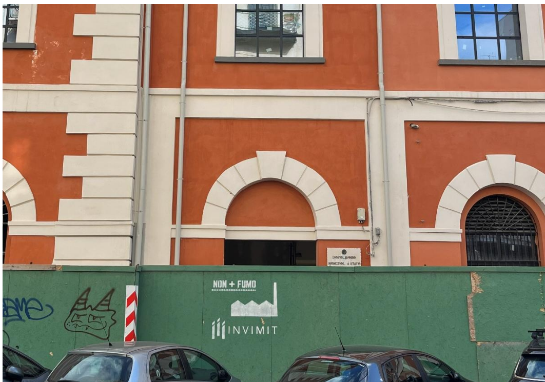
10. Presenza di transenne con loghi INVIMIT, NON+FUMO , 2025.
