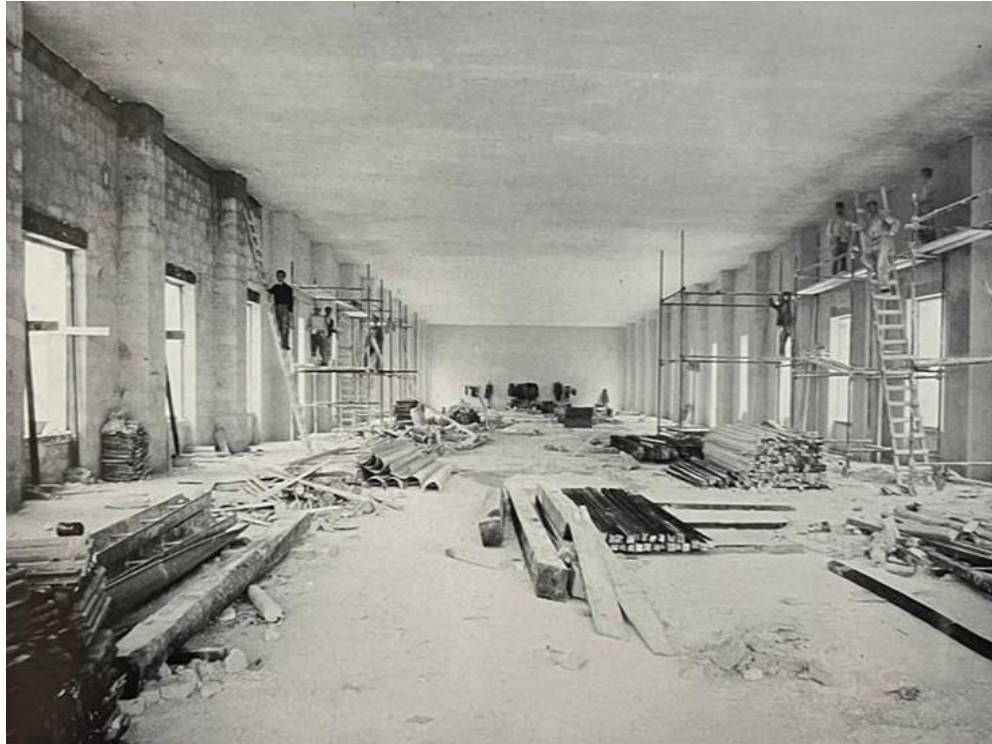
11. Manifattura Tabacchi di Bari, Sopraelevazione edificio su via Libertà tra via Nicolai e via Crisanzio, foto del cantiere dell'impresa ing. Alfredo Ladisa, primo piano, 1955-'58. Da R. CERVINI, MAURO SCIONTI, La Manifattura Tabacchi di Bari cit. p.3.
