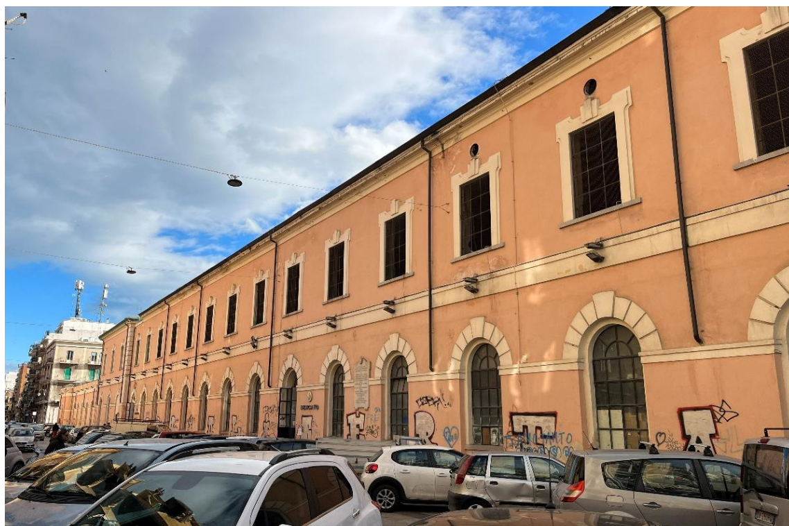
12. Fronte nord della Manifattura lungo via Nicolai, 2025.
