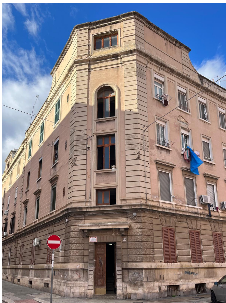
27. Case destinate agli alluvionati, Via Libertà 65, Bari, 2025.
