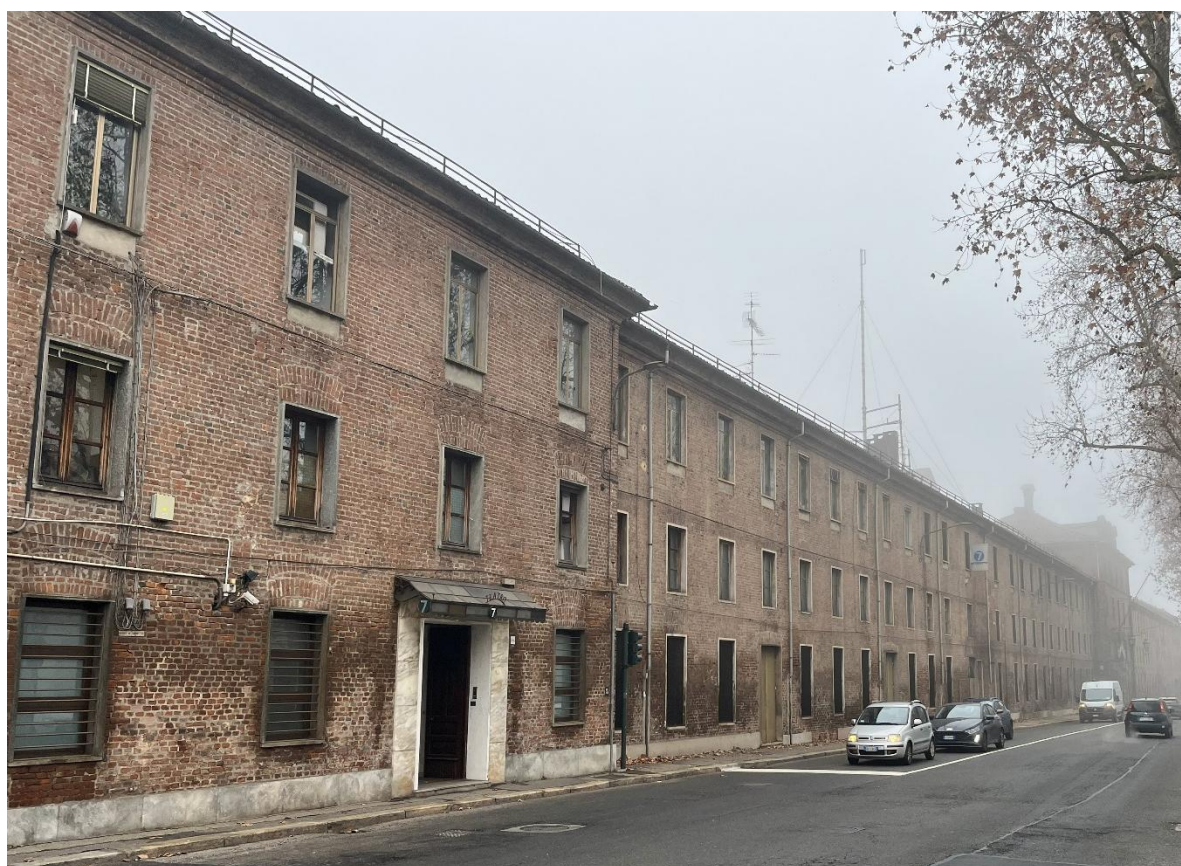
18. Ingresso rete 7 Piemonte, 2025.
