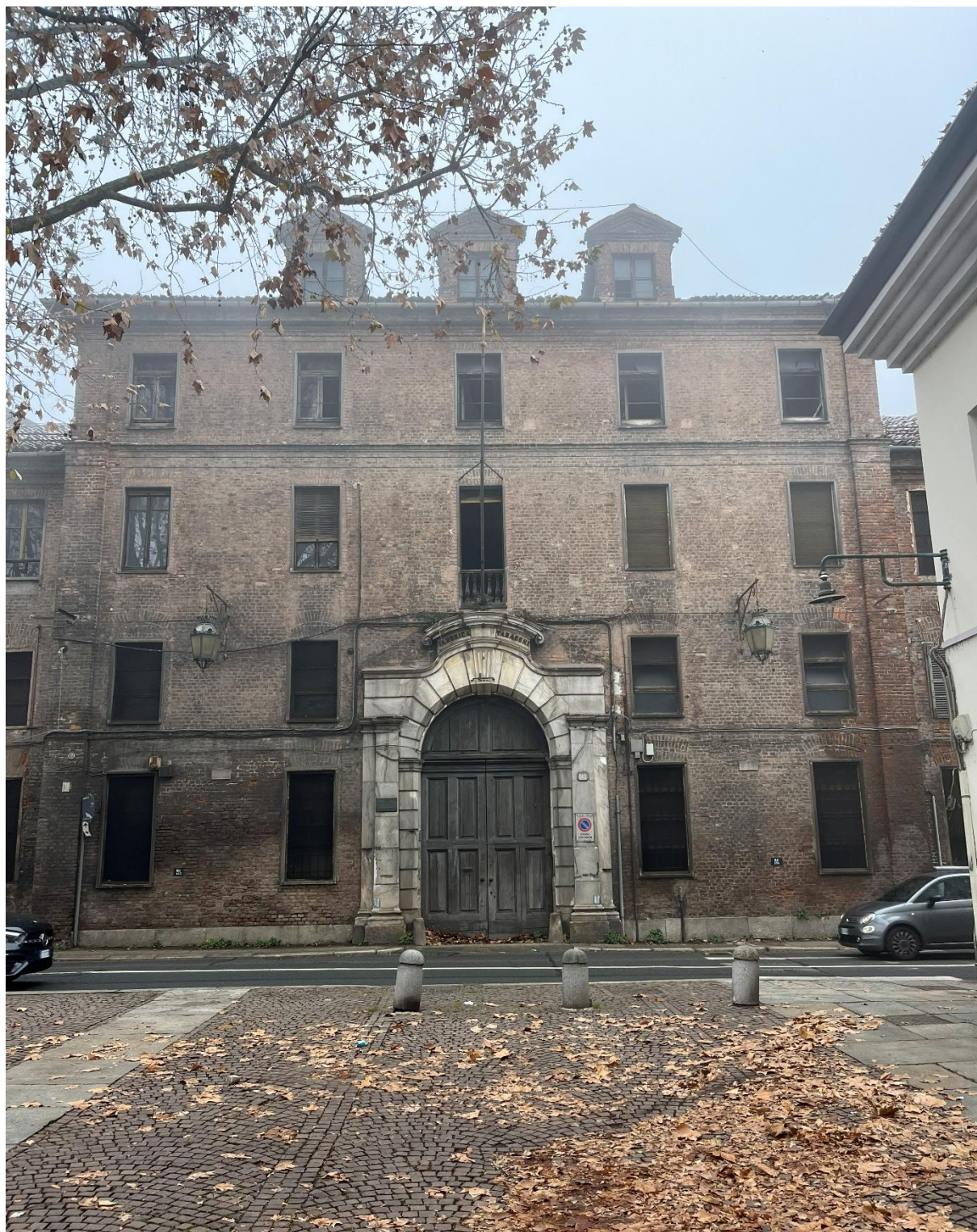
22. Accesso principale alla Manifattura su corso Regio Parco, 2025.
