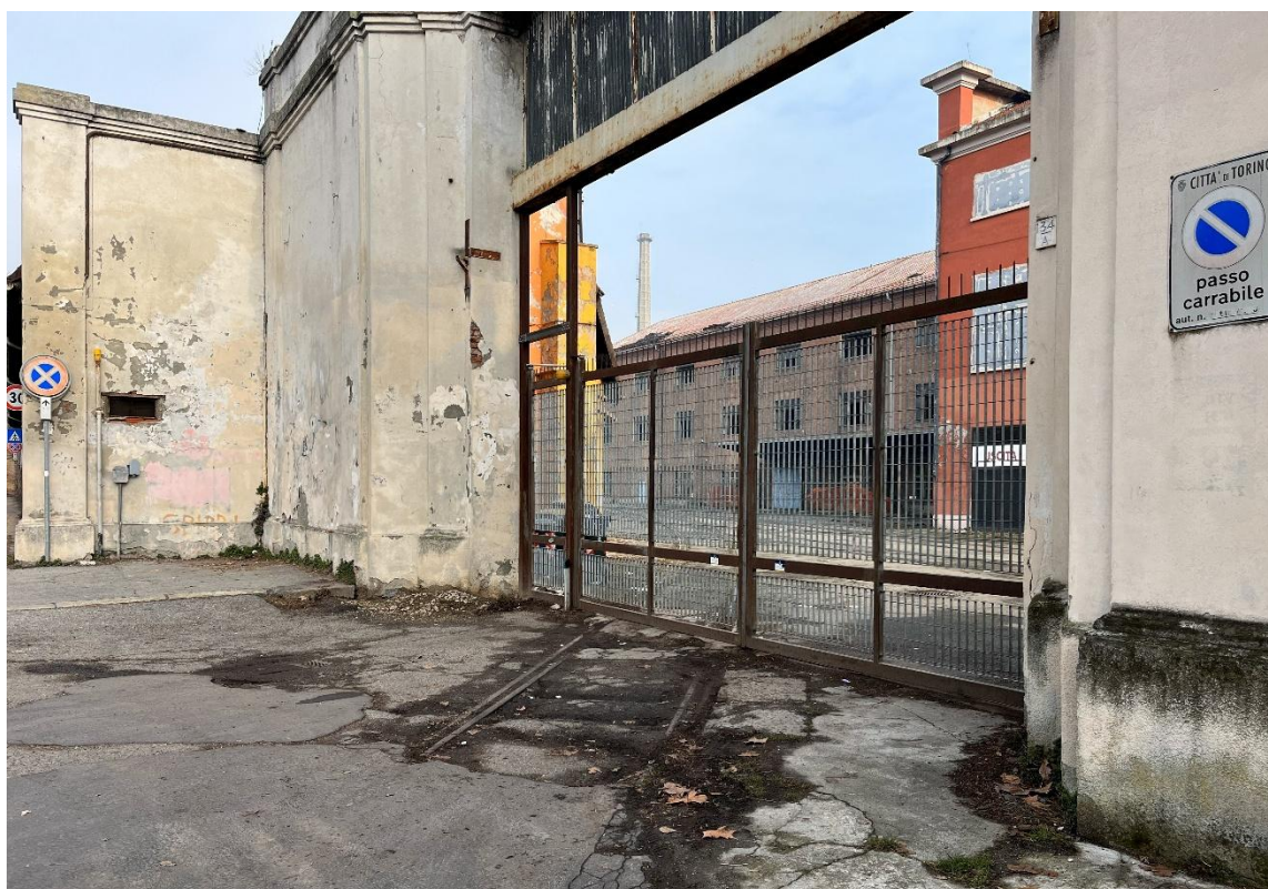
24. Accesso veicolare da corso Regio Parco al complesso della Manifattura con permanenze dei binari un tempo collegati allo Scalo Vanchiglia, 2025.
