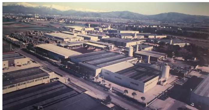
Figura [22] a destra Panoramica di una segheria specializzata ad Udine
