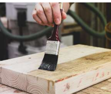
Figura [18] Esempio di primerizzazione con pennello.
