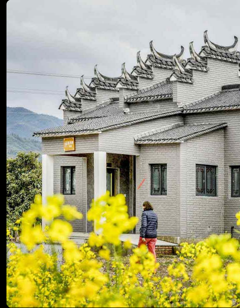
Figura 25 Foto di un bagno pubblico ben progettato e circondato da vegetazione nel villaggio di Kantou, comune di Hengxi, contea di Xianju, provincia dello Zhejiang, nella Cina orientale.
