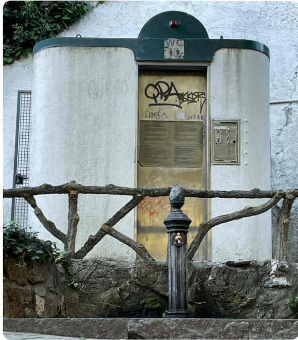
Figura 46 Aspetto esterno di una stazione WC, nei pressi di Piazza Corvetto, a Genova.
