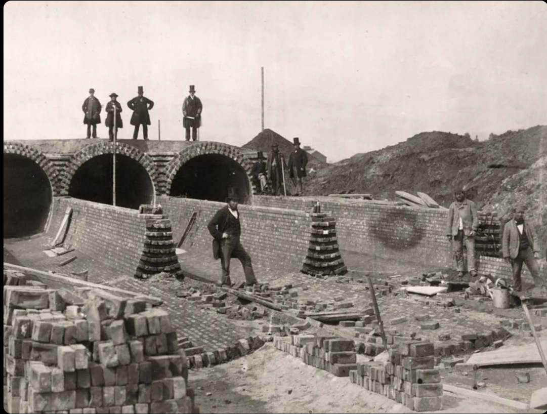
Figura 10 Fotografia della fognatura Northern Outfall , in costruzione sotto la stazione di pompaggio di Abbey Mills, nel 1862.
