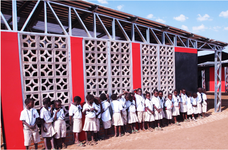
Struttura in mattoni, acciaio e copertura in lamiera ondulata.
