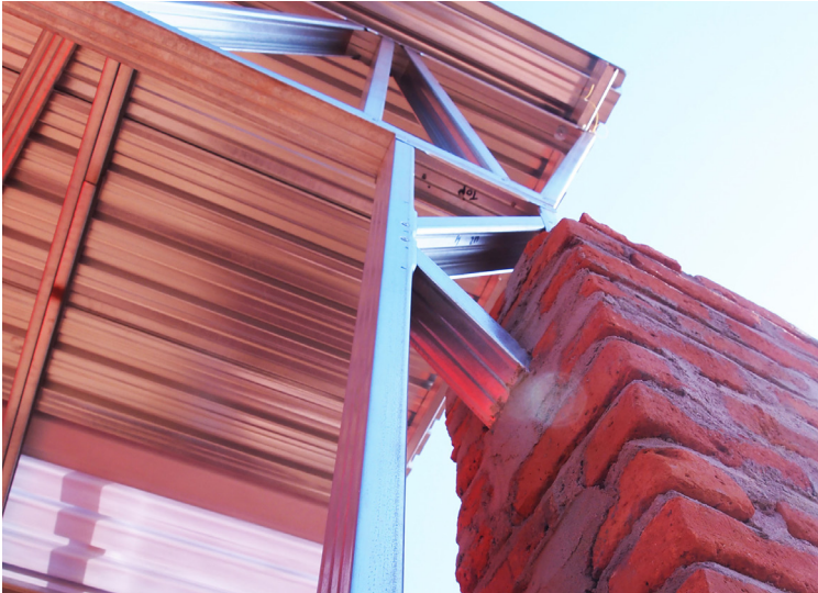
Struttura in mattoni, acciaio e copertura in lamiera ondulata.
