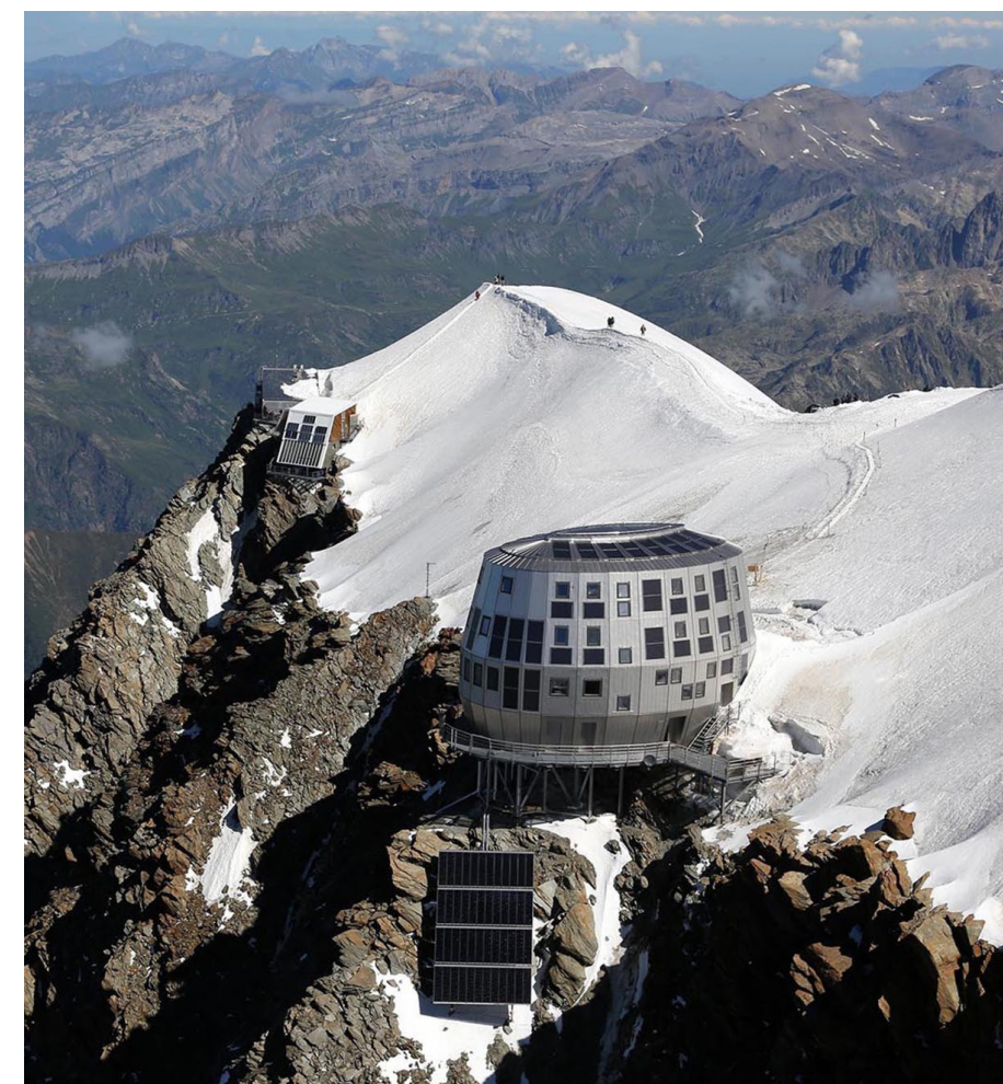
fig 20: Impianto fotovoltaico del Rifugio Aiguille du Goûter, Francia
