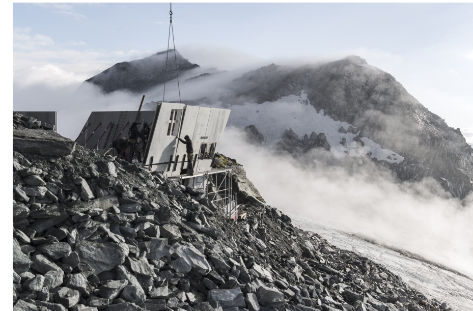
fig 22: I primi due piani a contatto con la roccia realizzati come elementi prefabbricati in calcestruzzo, Rifugio Sasso Nero, Italia
