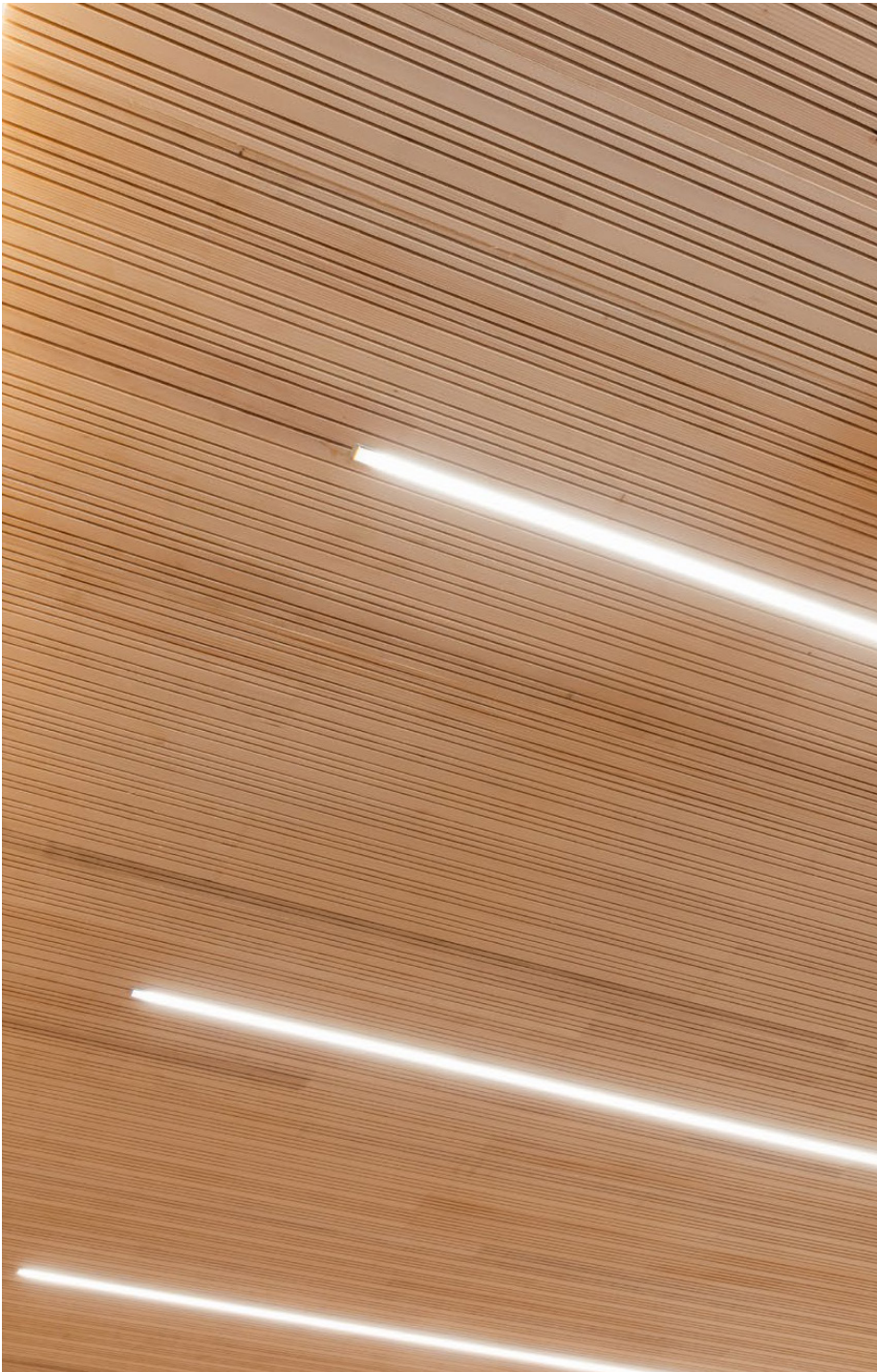
fig 75: Applicazione a soffitto del pannello fonoassorbente Hasslacher
