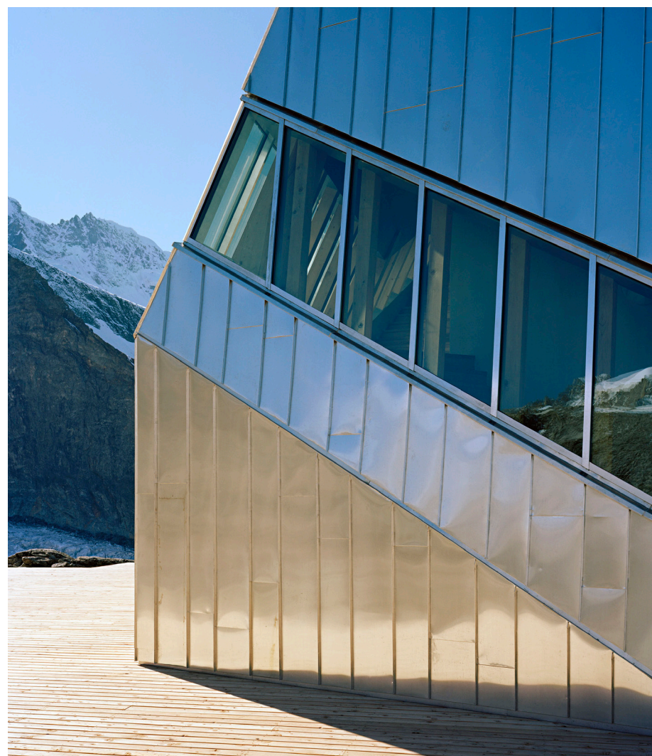
fig 21: Rivestimento involucro e ampia finestra a nastro del Monte Rosa Hütte, Francia
