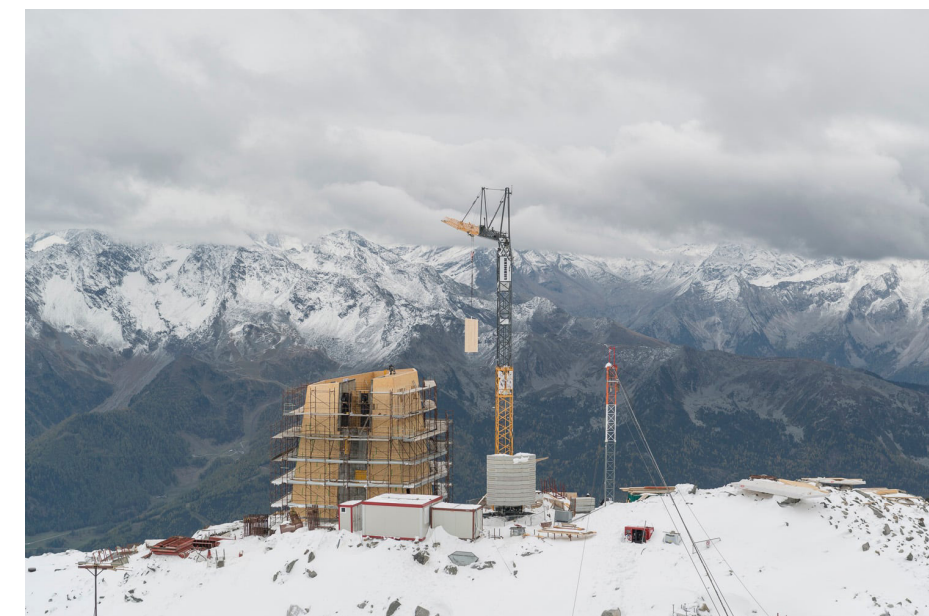
fig 23: Ultimazione dei principali lavori prima della pausa invernale, leggerezza della struttura prefabbricata in legno in contrasto con il peso del basamento in calcestruzzo, Rifugio Sasso Nero, Italia
