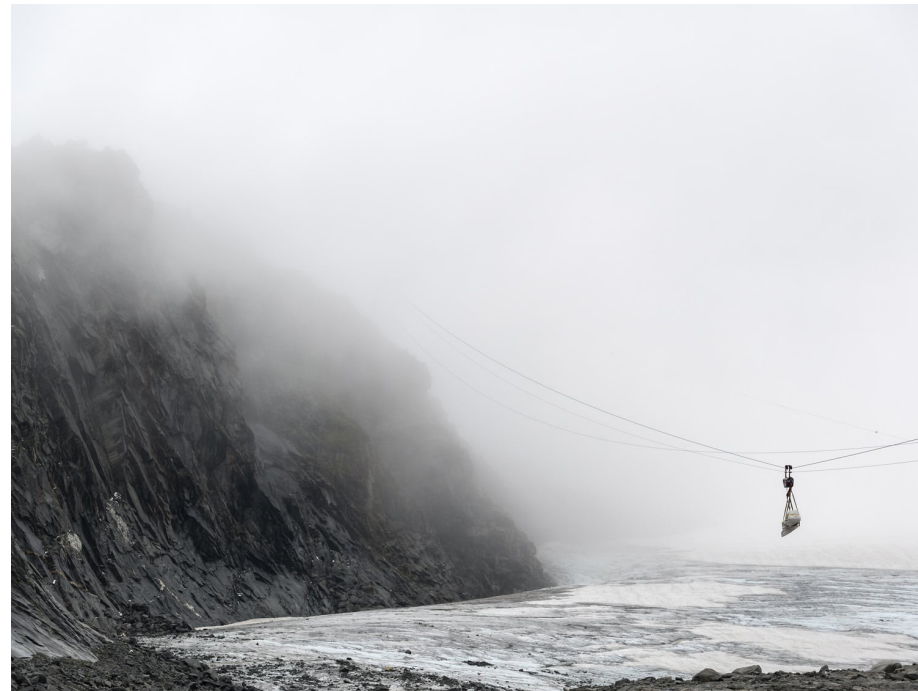
fig 24: Il trasporto di materiale edile tramite teleferica riduce il numero di rotazioni in elicottero, Rifugio Sasso Nero, Italia
