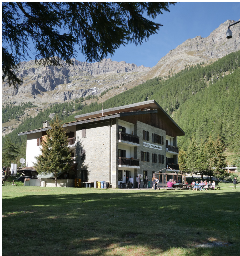
fig 29: Rifugio Mila di proprietà di un'azienda idroelettrica locale, Ceresole Reale, Italia
