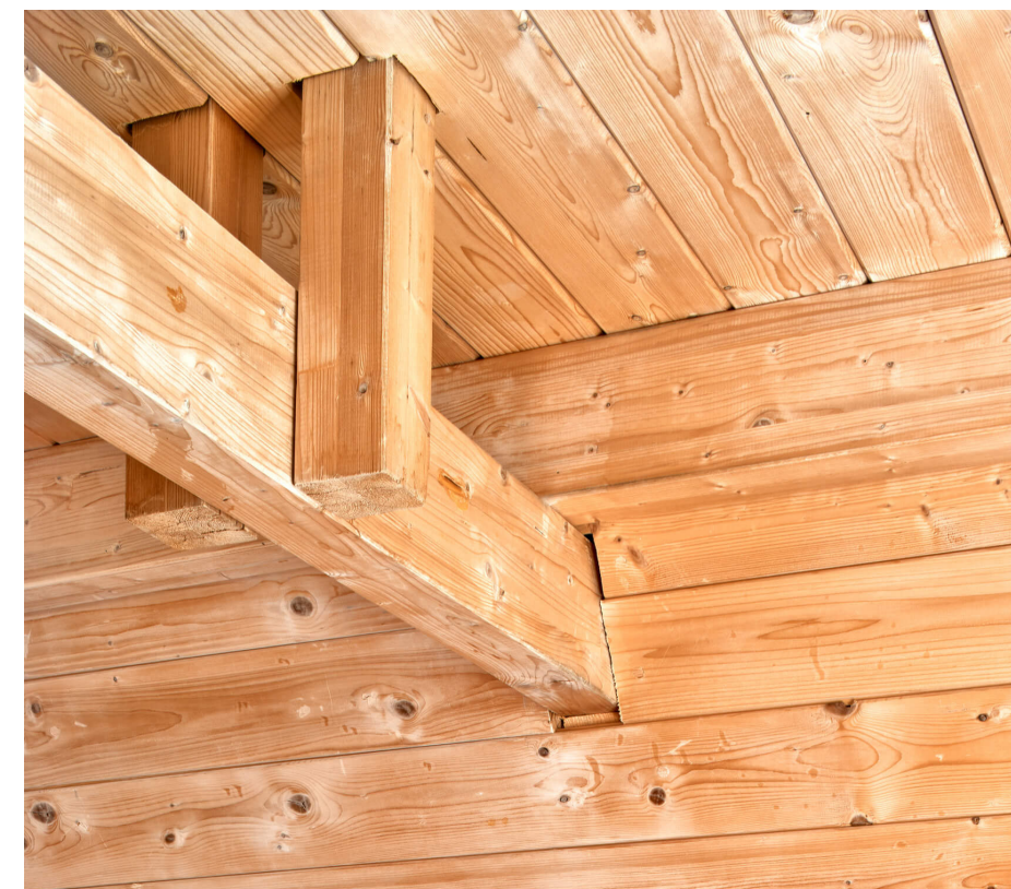
fig 70: Rivestimenti interni con doghe e perline in legno di conifera, Rifugio Mollino, Italia
