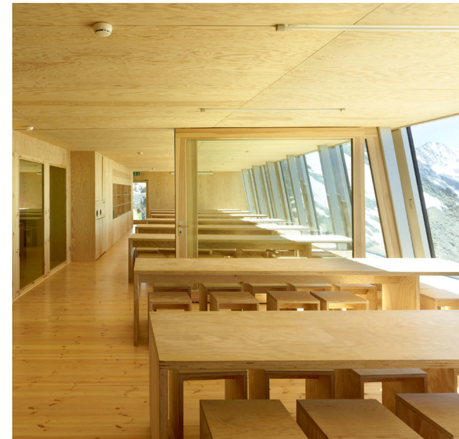
fig 16: Arredo e rivestimenti in multistrato abete, interni Cabane de Tracuit, Svizzera
