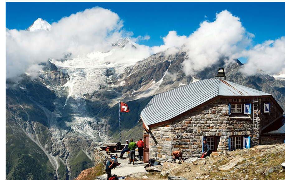
fig 53: Corpo centrale del 1957, Domhütte, Svizzera
