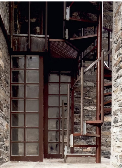
fig 73: Scala in lamiera, calcestruzzo e gomma, Rifugio Vallanta, Italia
