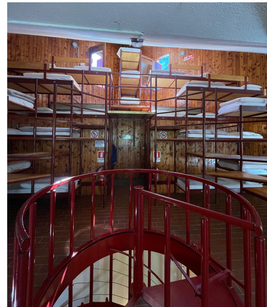
fig 17: Interni Rifugio Vallanta, struttura dei letti e della scala a chiocciola in acciaio verniciato
