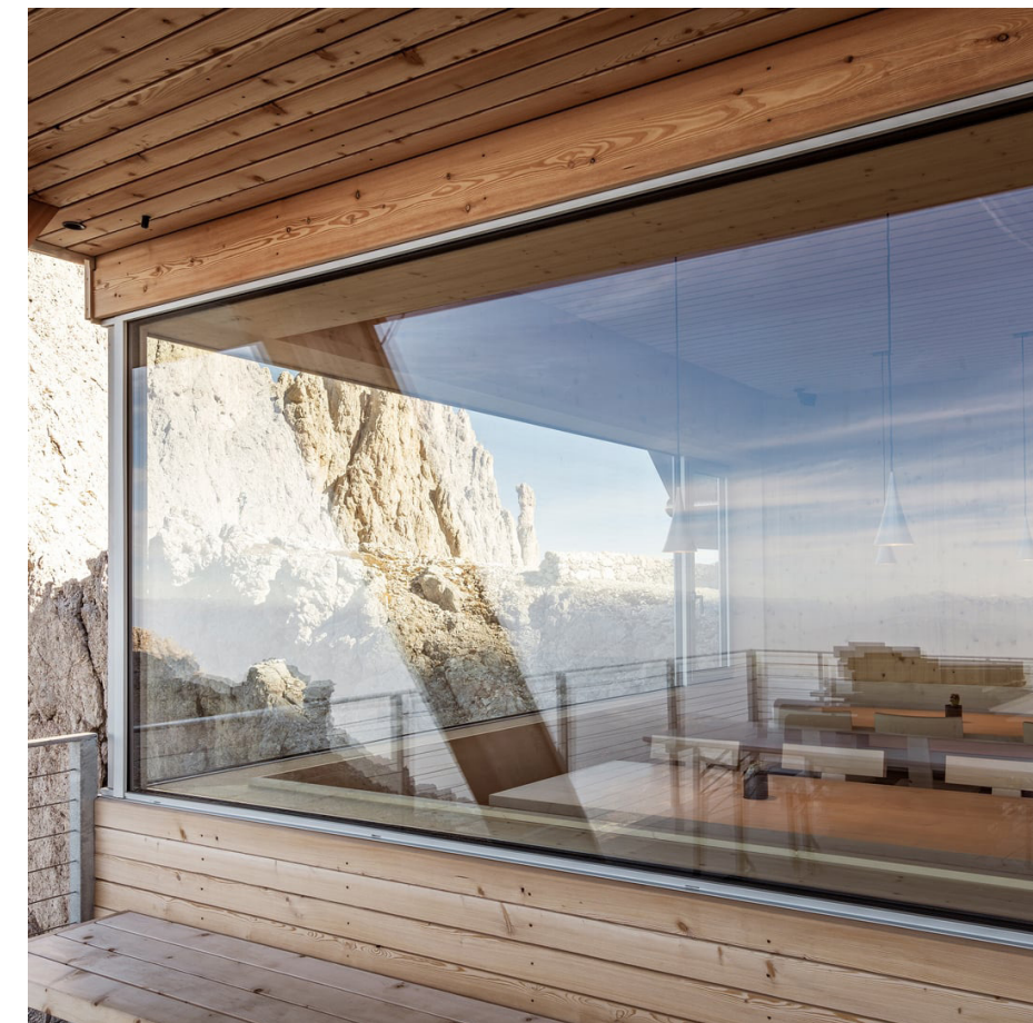
fig 69: Ampia finestra a nastro Finstral triplo vetro, U_w = 0.77 , Rifugio Passo Santner
