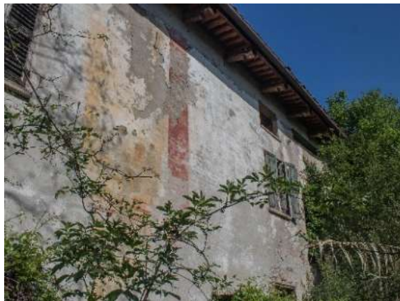
Figura 36: Facciata Ovest di Cascina Sbriggia
