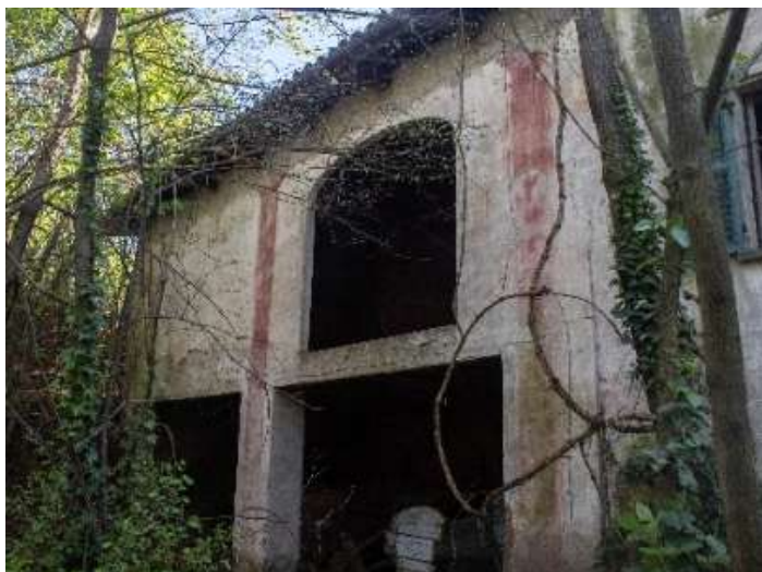
Figura 34: Facciata Ovest Cascina Sbriggia
