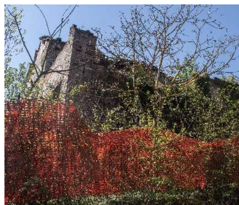
Figura 30: Facciata Nord di Cascina Giacomotta
