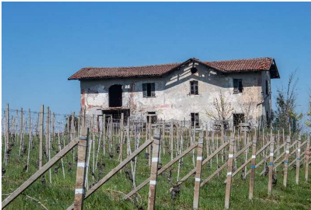
Figura 14: Facciata Ovest di Cascina Aurelia
