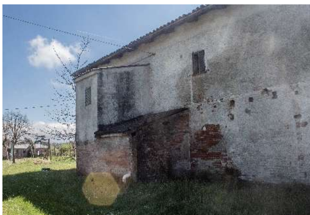
Figura 26: Facciata Nord di Cascina Nuova
