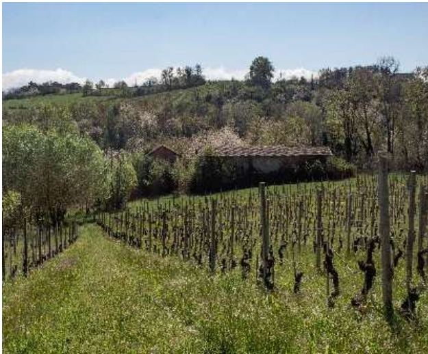
Figura 18: Facciata Sud di Cascina Certa
