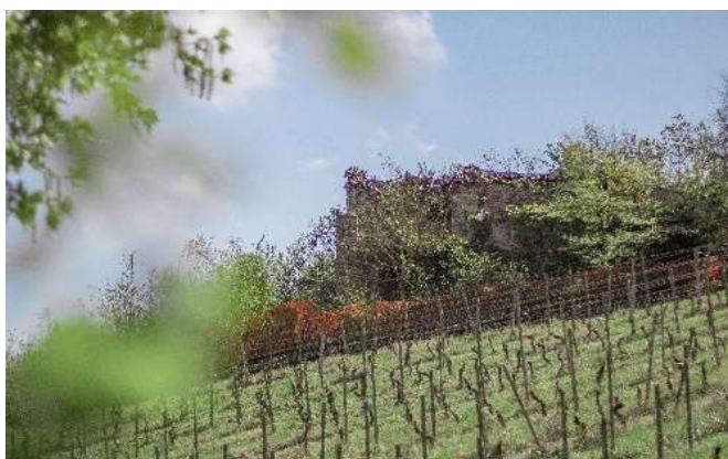
Figura 29: Facciata Nord di Cascina Giacomotta
