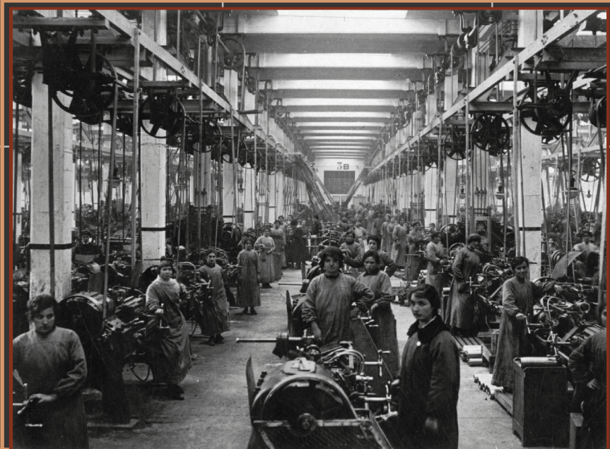
Produzione bellica, proiettili del cantiere navale di Sestri Ponente
