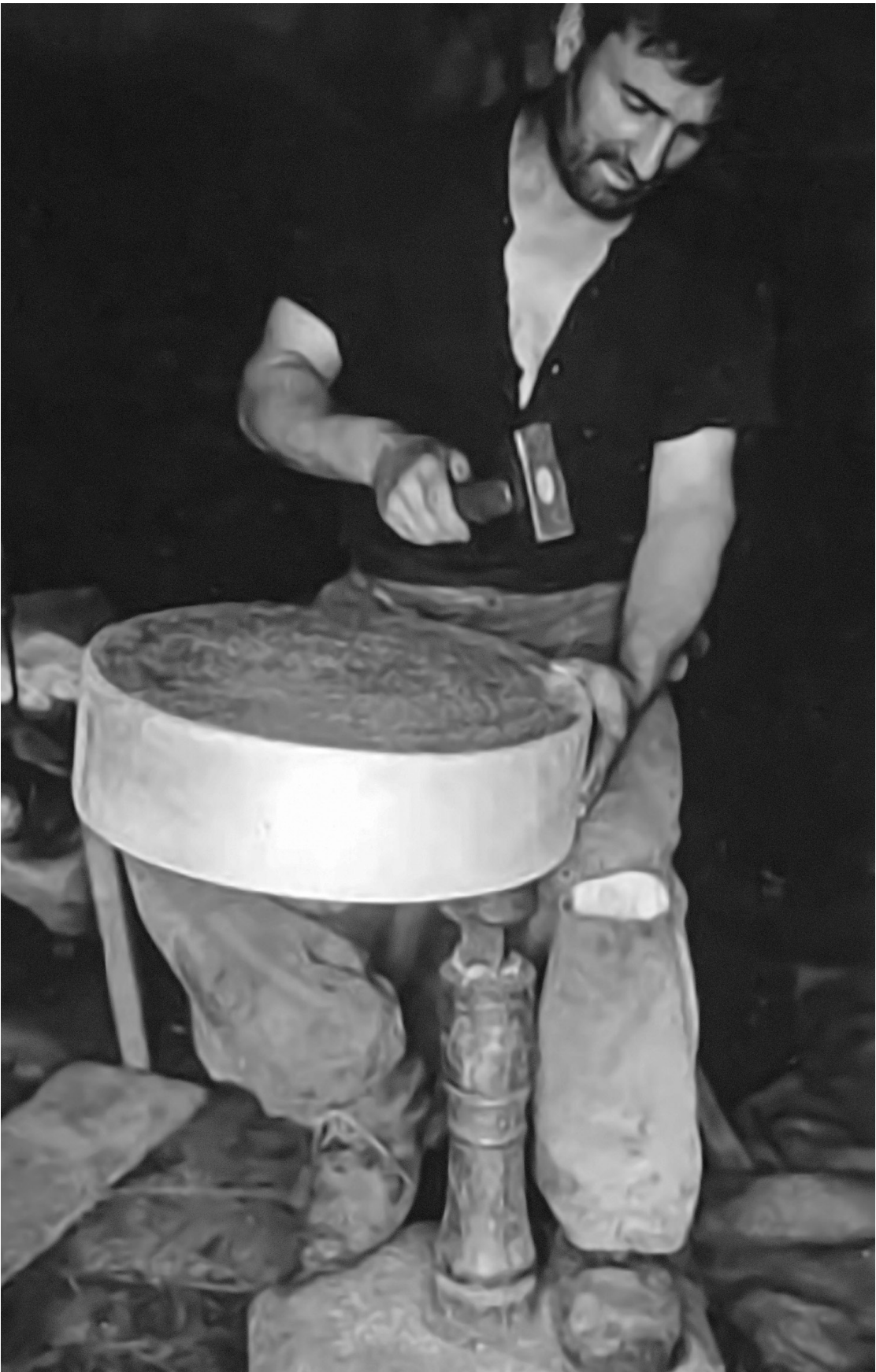
Battitura a mano eseguita nella ramera Aimonetto di Sparone, Marco Cima, “Archeologia del rame, Il caso del Canavese Estrazione, metallurgia e sistemi produttivi”, Nautilus, Torino, 2025 p.75
