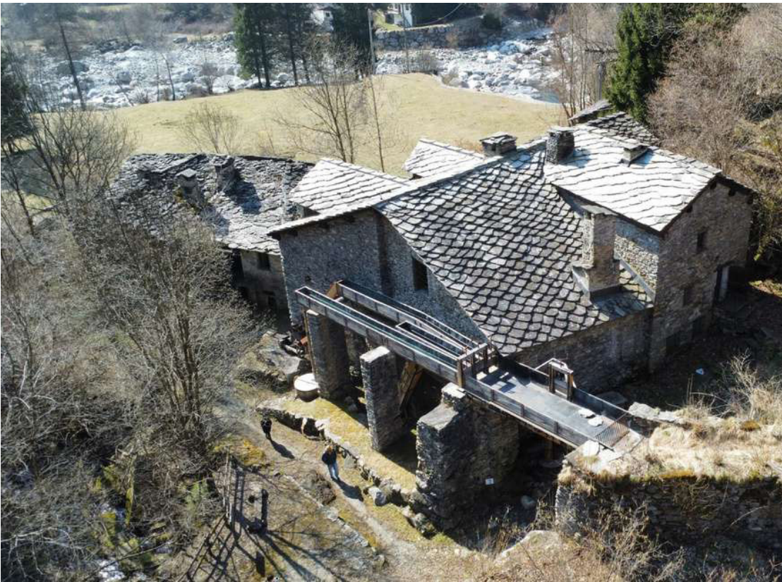
Foto aerea della porzione retrostante della borgata Castellaro,
