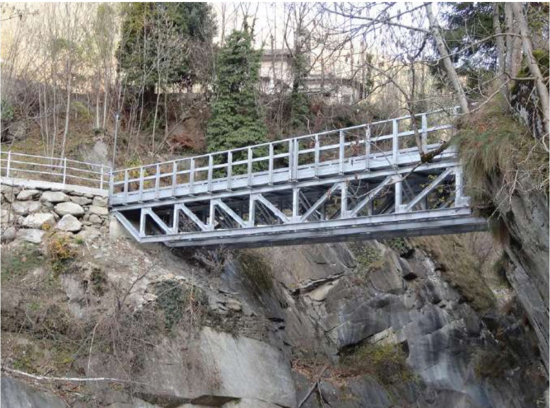
Veduta del nuovo ponte che collega la borgata al comune
