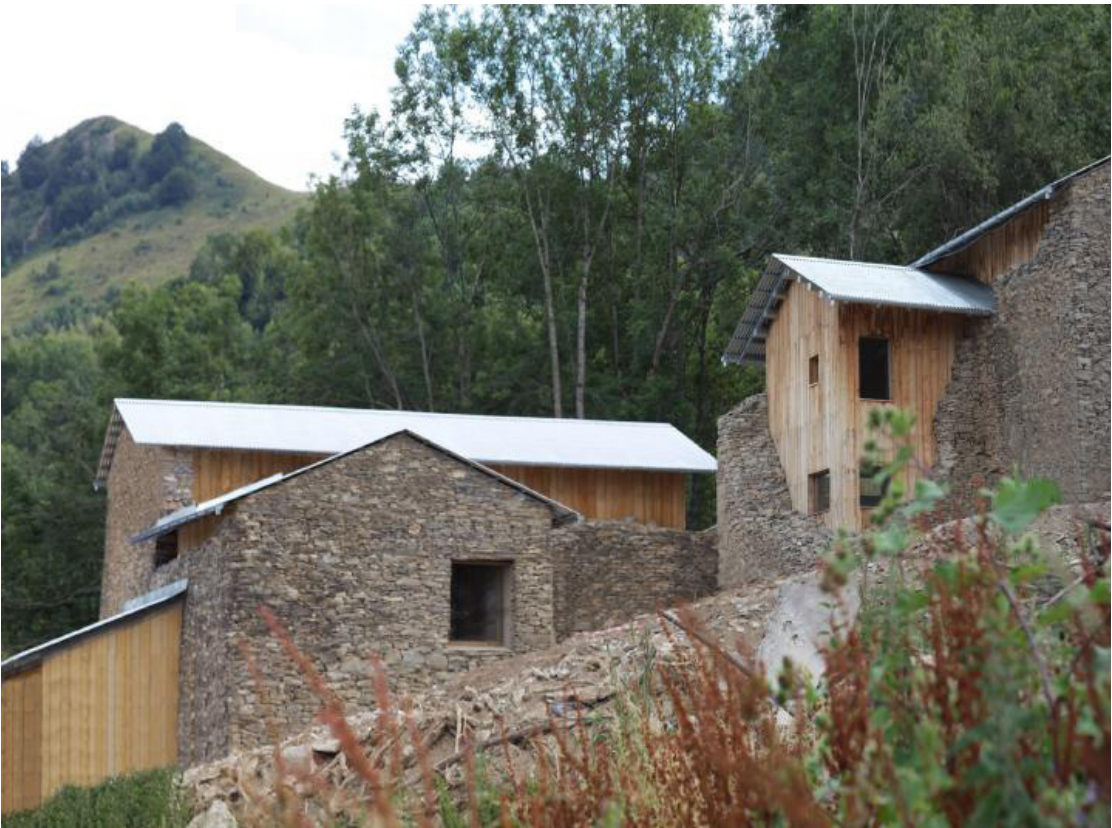
Dario Castellino, Valeria Cottino, Borgata Paraloop, Rittana. Valeria Cottino Architetto, “Borgata Paraloop il recupero”, https://www.valeriacottino.it/borgata-paraloop , (Ultima consultazione gennaio 2026)
