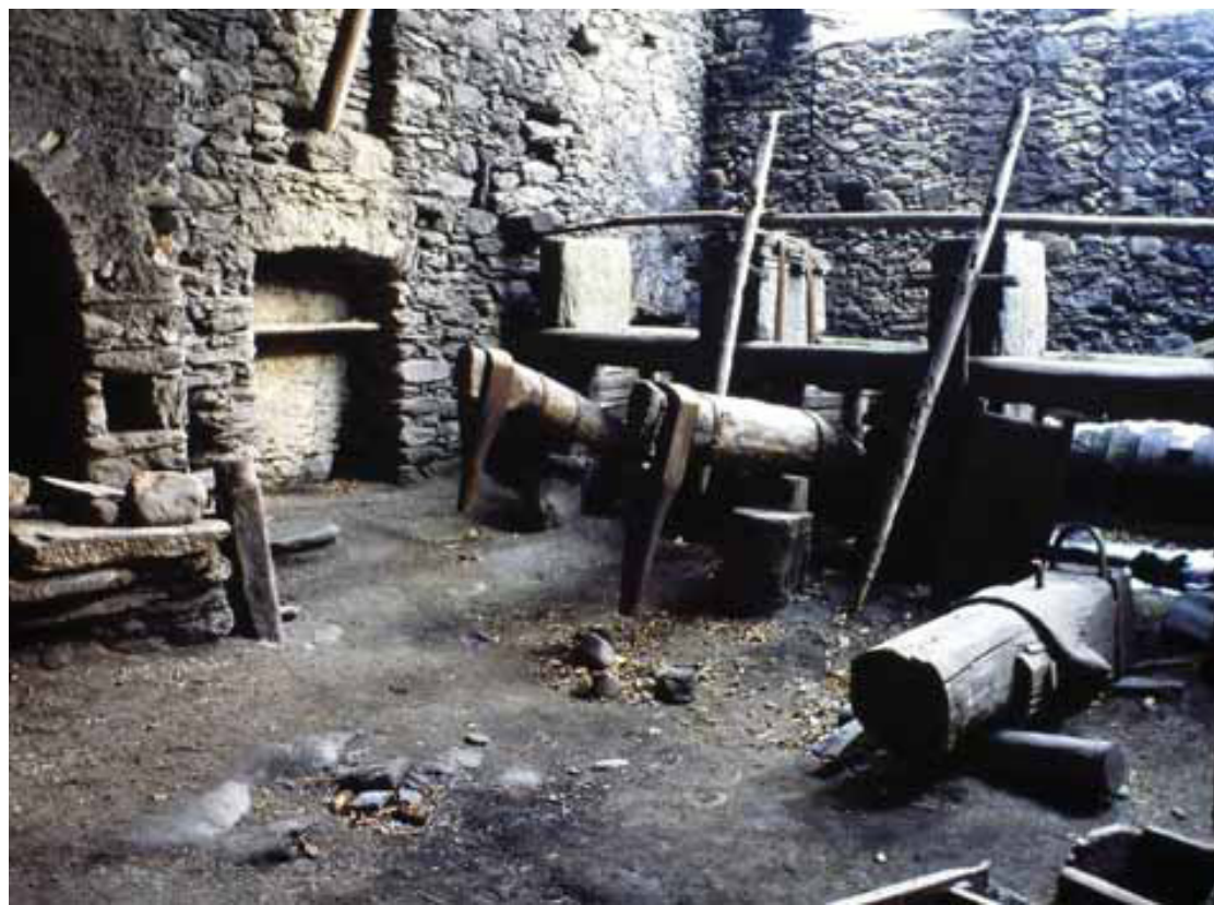
Veduta d'insieme della batteria di magli principale. Marco Cima, "Archeologia del rame, Il caso del Canavese Estrazione, metallurgia e sistemi produttivi", Nautilus, Torino, 2025 p.101
