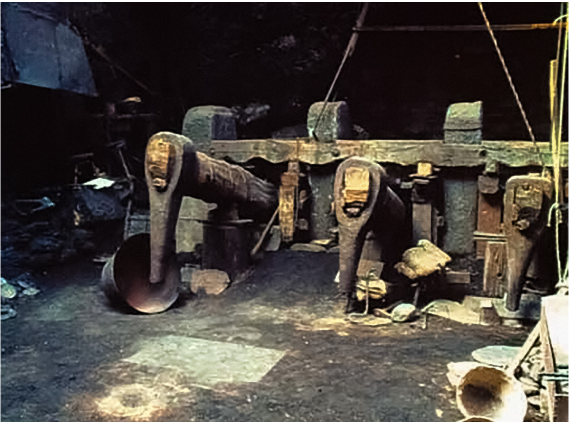
Batteria dei Magli a testa d’asino della Fucina Giovando a Sparone. Marco Cima, “Archeologia del rame, Il caso del Canavese Estrazione, metallurgia e sistemi produttivi”, Nautilus, Torino, 2025 p.71
