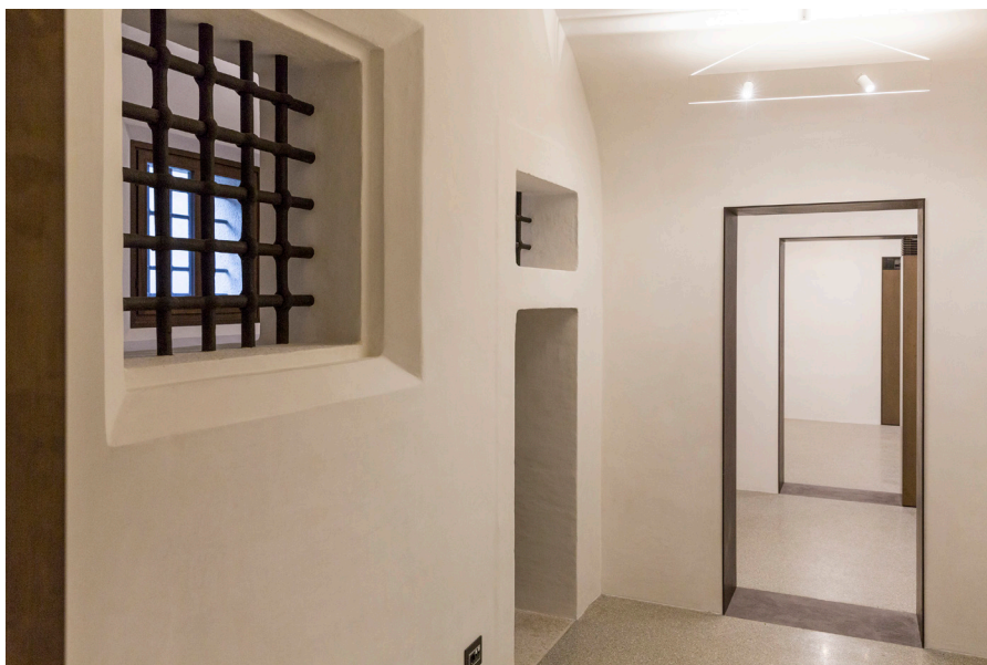
Fig. 21_ Carceri Asburgiche, Treviso, nuovi varchi nelle murature, (Fotografia di Marco Pavan, 2020).
