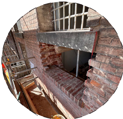
DETTAGLIO intervento ampliamento finestre (Fotografia d'autore, 2025)
