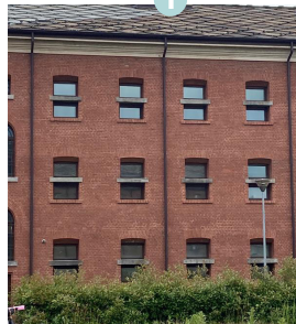
Buono stato di conservazione.
