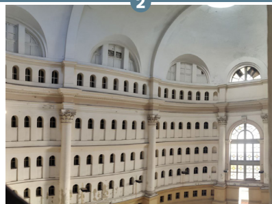
Piccole porzioni di degrado superficiale.
