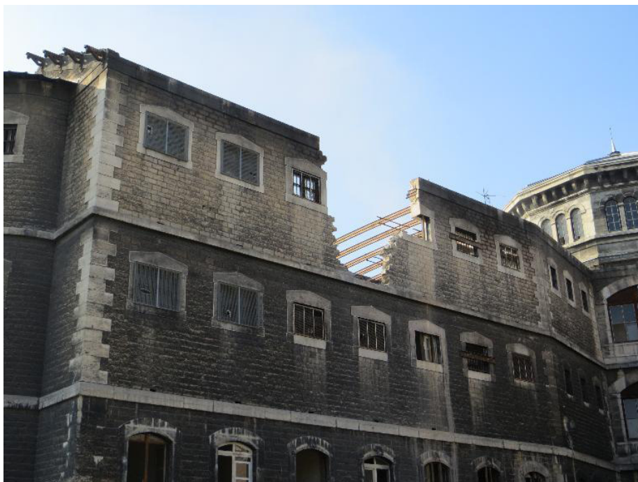
Fig. 25_ Carcere di Saint-Paul , Lione, smantellamento di porzioni di edificio, (Fotografia di Veronica La Bella, 2013)
