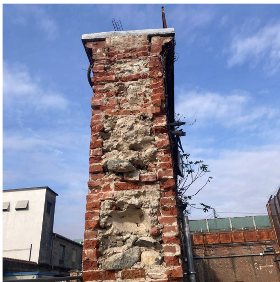
Fig. 44_ Carceri Le Nuove, Torino, Muro di cinta a sacco Fotografia d'autore, 2025
