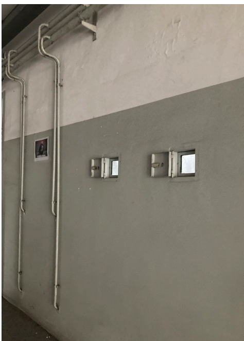
Fig. 60_ Carceri Le Nuove, Torino, fessure per controllare i detenuti (Fotografia d'aut., 2023)
