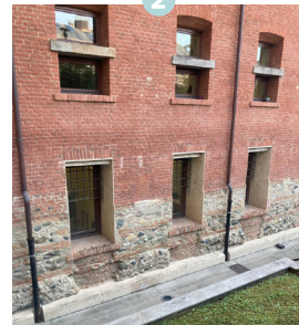
Buono stato di conservazione.
