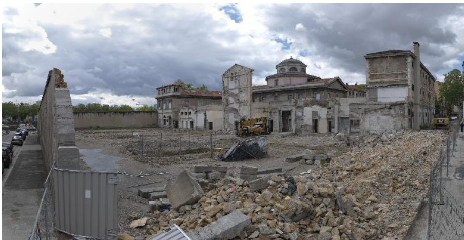
Fig. 26 _ Carcere di Saint-Joseph, Lione, visuale delle estese demolizioni effettuate, (Fotografia di Eric Dessert, 2013)
