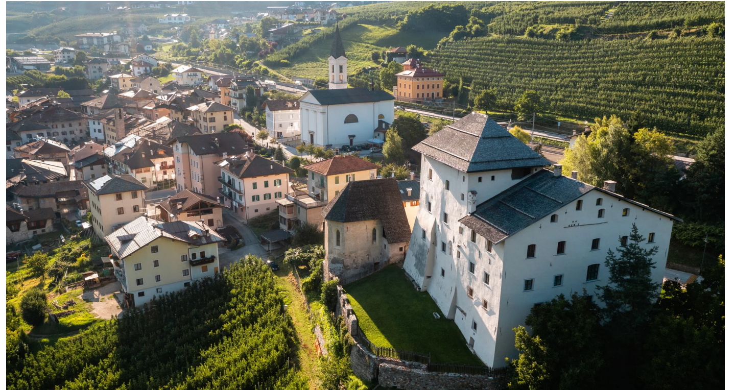
▲ fig. 3.26 Castel Caldes, foto di Visit Val di Sole, 2021
