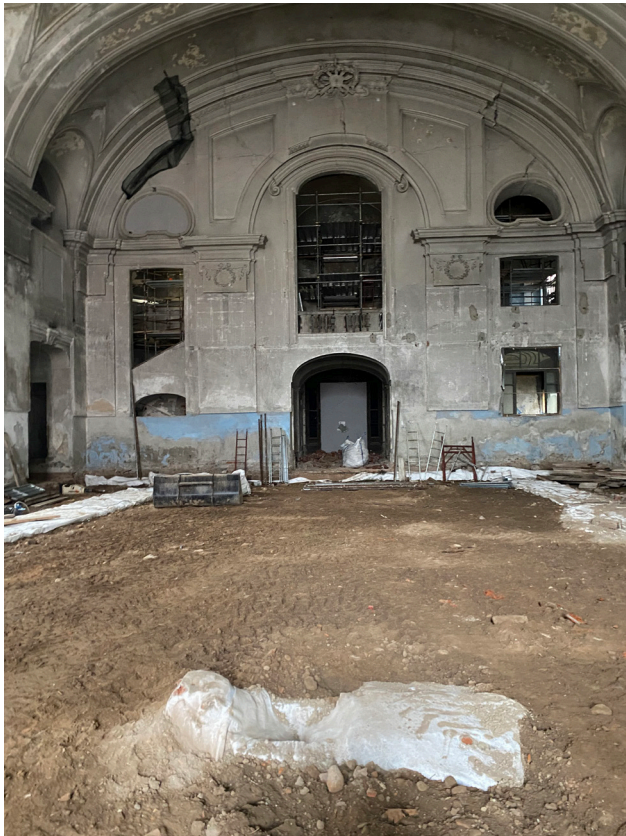
Figura 14 ▼ Interno del Maneggio Alfieriano, facciata di collegamento alle altre maniche del complesso
