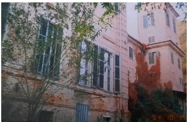
Fotografia A23 1994 , s.a., Prospetto est del castello, datata 17 ottobre 1994, APFV, Castello di Pessione , fotografie storiche.
