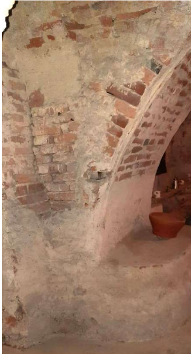
Figura 13. Muratura a scarpa che evidenzia l'unione di due fasi costruttive (fotogr. 23 apparati).
