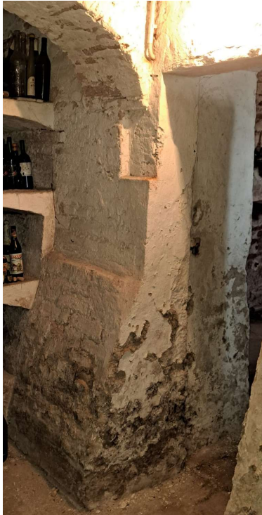
Figura 12. Muratura a scarpa nel seminterrato del castello (fotografia n° 23 apparati).
