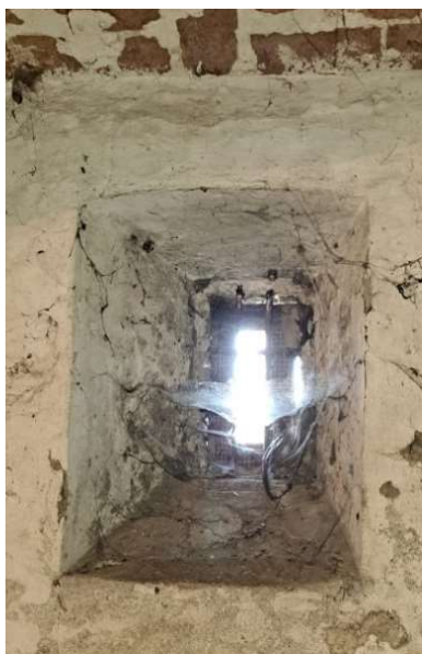
Figura 3. Feritoia presente nel seminterrato del castello (fotografia n° 24 apparati).
