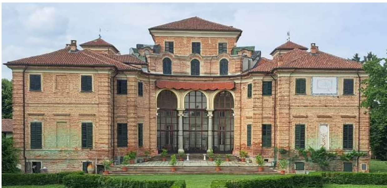
Figura 14. Facciata meridionale del castello. Si notano in questa fotografia le colonne in pietra di Malanaggio e lo scalone in pietra di Luserna e di Cumiana, risalenti alla seconda metà del Settecento (zoom fotografia n° 20 apparati).
