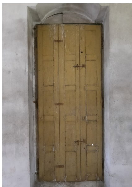
Fotografia n° 54 (torre di ponente)
