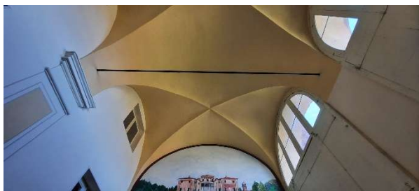
Figura 11. Androne con volte a crociera (fotografia n° apparati).
