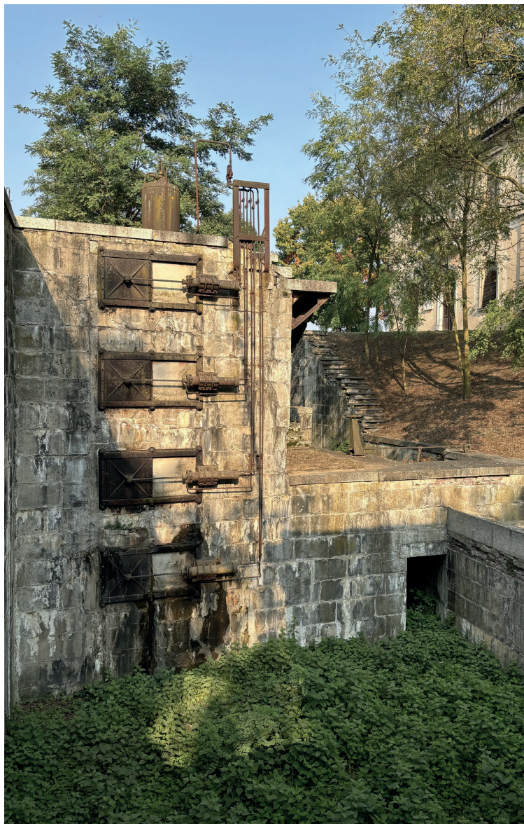
18 | Torre degli efflussi, vasca minore di misurazione, apri-serra delle piccole portate Foto dell'autrice
