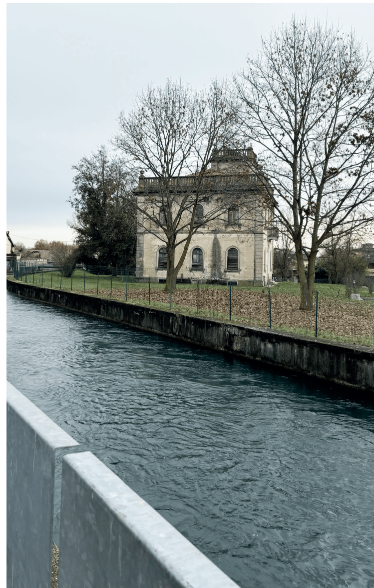
Vista della stazione idrometrica dal belvedere infopoint Foto dell'autrice
