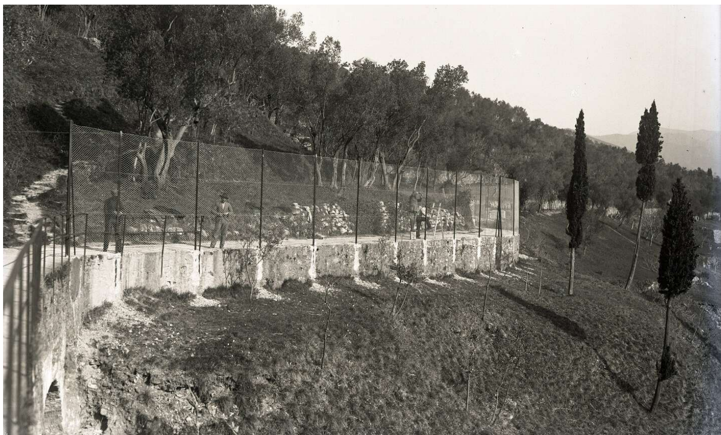
^ 19. Gabinetto Fotografico Municipale di Genova, Genova. Cinta daziaria. Da S. Bartolomeo di Staglieno sull'acquedotto, 1921, fotografia b/n. Genova: Centro DocSAI, 1754.
