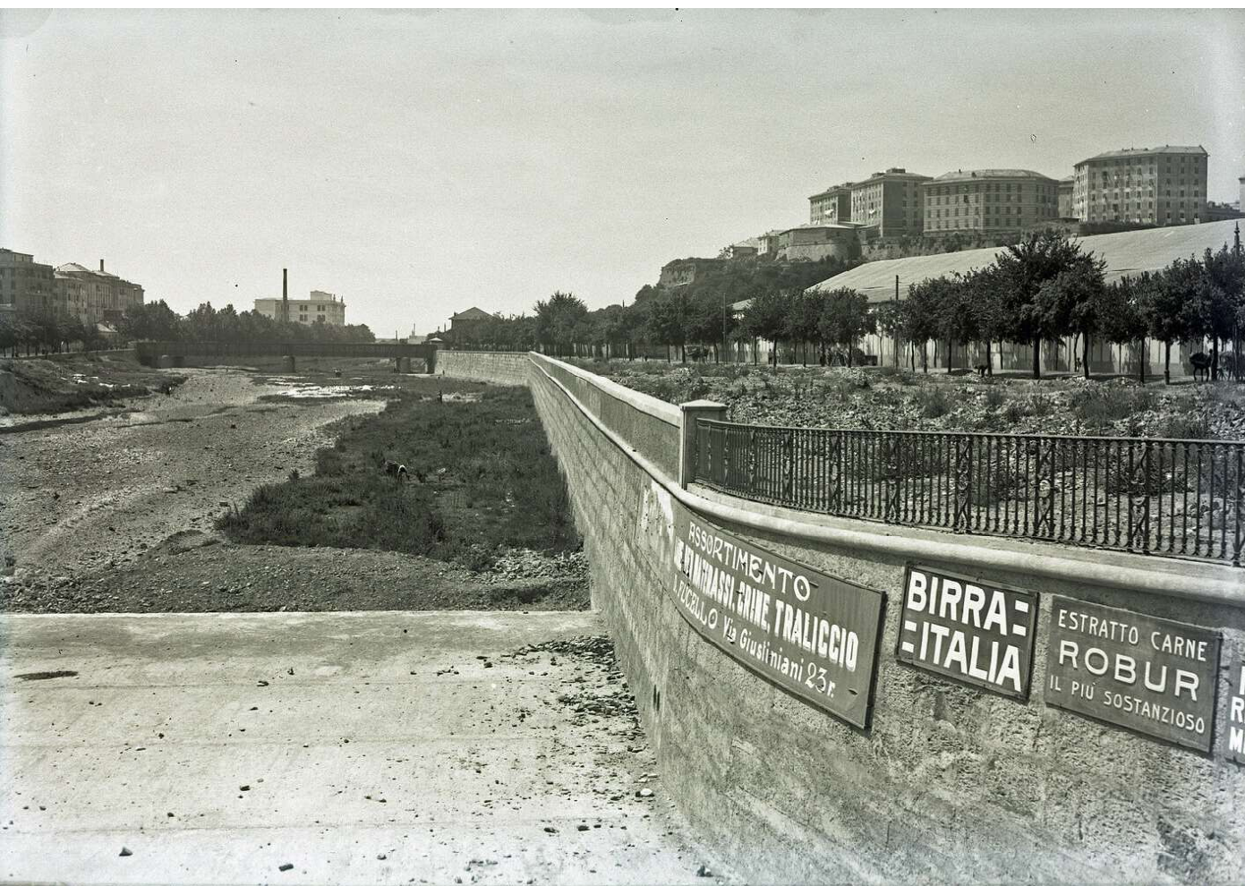
^ 51. Gabinetto Fotografico Municipale di Genova, Genova. Lavori di copertura del Bisagno. Argine a monte di Porta Pila, sd , fotografia. Genova: Centro DocSAI, 3081.
