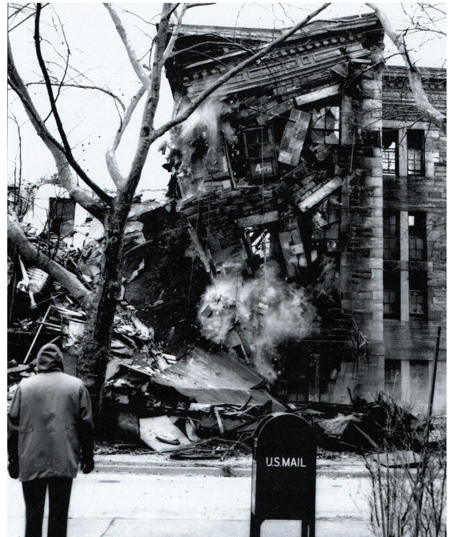
Figura 2.20. Demolizione, avvenuta nel 1970, dell'ala ovest dell'edificio che ospitò prima il Lunatic Asylum e poi il Metropolitan Hospital. [Berdy, Roosevelt Island, 92]
