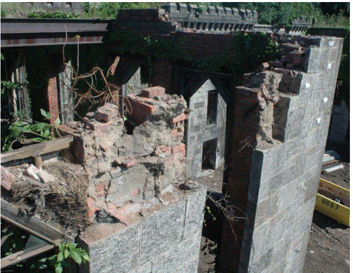
Figura 2.39. Dalla rovina dello Smallpox emerge la sua stratigrafia costituita da laterizio e rivestimento in gneiss. [John Milner Associates, Smallpox Hospital Ruins. Phase 1A Emergency Stabilization Completion Report , 2009]
