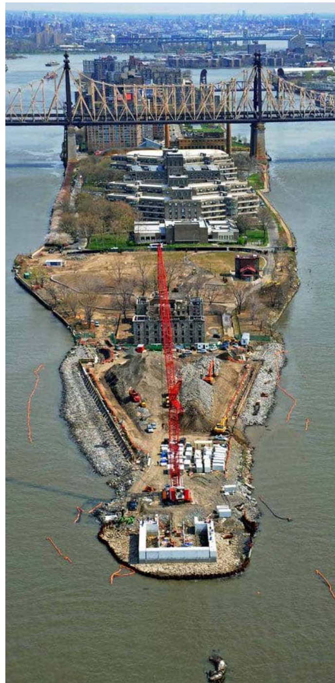
Figura 2.24. Vista aerea di Roosevelt Island con il Franklin D. Roosevelt Four Freedoms Park in costruzione. [“Franklin D. Roosevelt Four Freedoms Park,” Sciamé, ultimo accesso 5 dicembre 2024, https://sciamé.com/portfolio/franklin-d-roosevelt-four-freedoms-park/ ]
