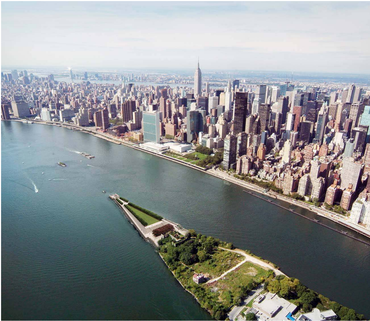
Figura 2.2. Vista aerea di Roosevelt Island con Manhattan sullo sfondo. [“Franklin D. Roosevelt Four Freedoms Park,” Sciamè, ultimo accesso 5 dicembre 2024, https://sciamè.com/portfolio/franklin-d-roosevelt-four-freedoms-park/ ]
