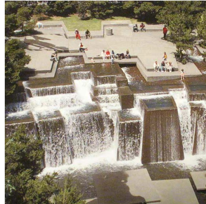
Figura 4.6. Vista aerea dell'Ira Keller Forecourt Fountain, realizzata da Lawrence Halprin and Associates tra il 1963 e il 1975 a Portland (Oregon). ["Ira Keller Forecourt Fountain," The Cultural Landscape Foundation, ultimo accesso 13 luglio 2025, https://www.tclf.org/sites/default/files/microsites/halprinlegacy/ira-keller-forecourt-fountain.html ]
