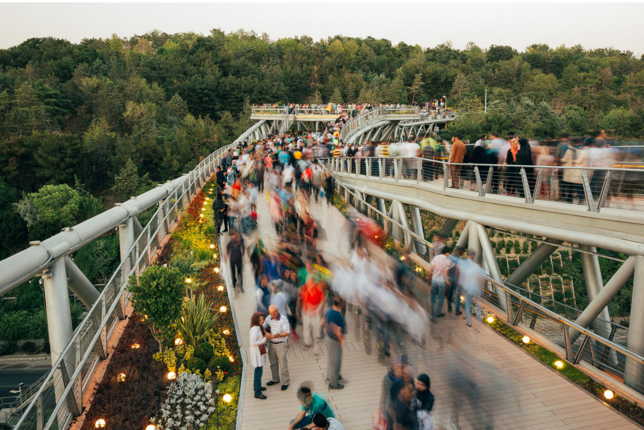
Fig. 1.38 - Ponte della Natura - percorso curvato e variazioni successive di larghezza e inclinazione dei piani rallentano gli utenti / Nature bridge - curved path and consecutive change in width and inclination of the floors slows down the users
