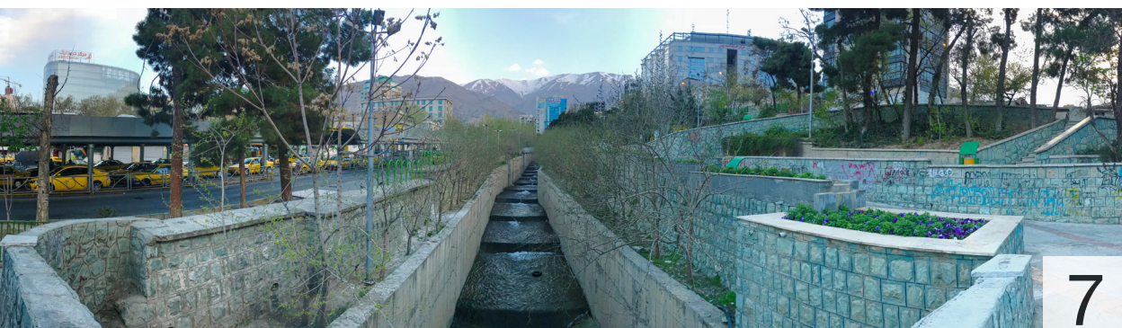
Fig. 3.42 - Da torrente a canale: argini alti in cemento, impermeabilizzazione e degrado percettivo / From stream to channel: high concrete embankments, hardscape and visual decay
