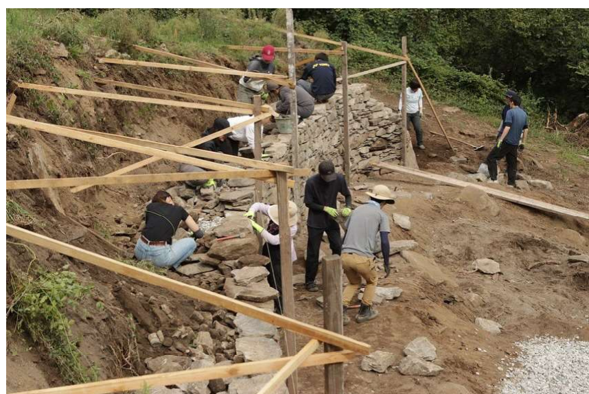
Studenti del Politecnico di Tokyo partecipano alla realizzazione di un muretto a secco per un terrazzamento, foto Fondazione CANOVA
