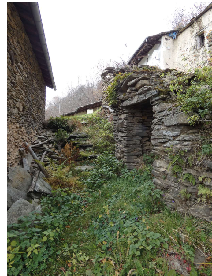
Passaggio pedonale in terra battuta con alcuni gradini realizzati con vecchie lose
