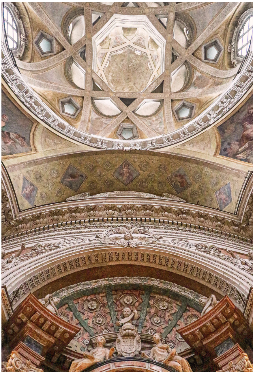
Fig. 1.6 In basso: vista dal basso da una delle cappelle assiali. In alto si nota la struttura ripetuta ad archi incrociati del lanternino.
