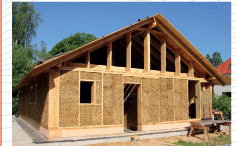
(1) legno come materiale strutturale, paglia come isolamento
