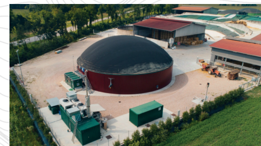
(2) Sistema di raccolta di biogas
