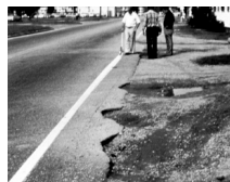
Edge cracking
