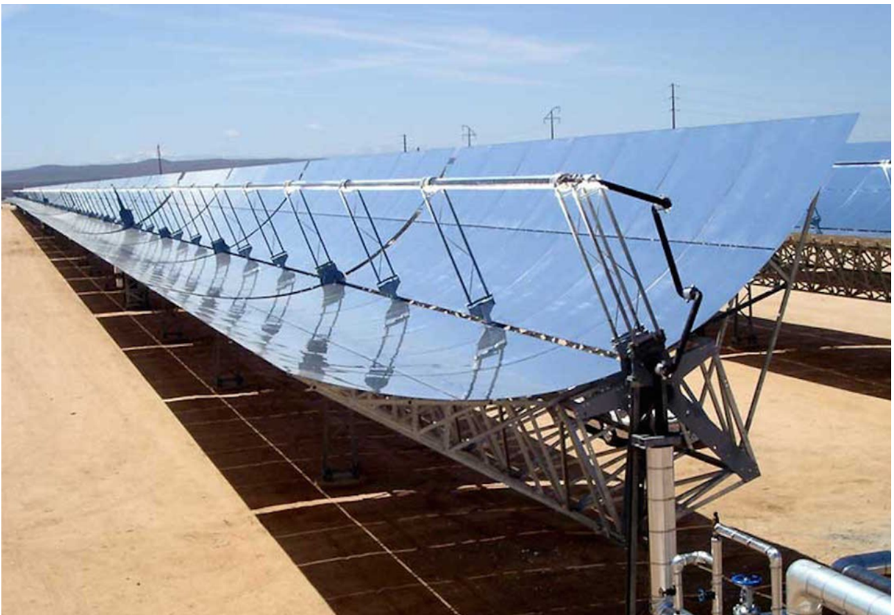
Figura 6: Impianto a collettori parabolici lineari in Ouarnzazate , Marocco (14)
