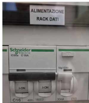
(a) Alimentazione del rack dati.
