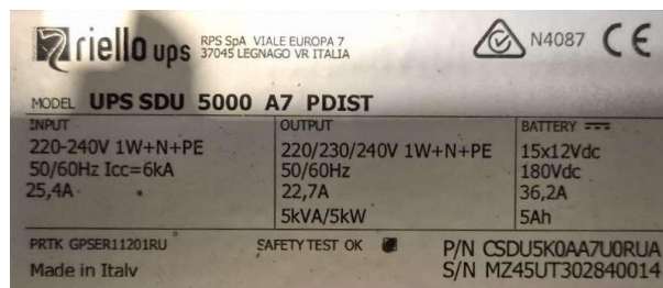
Figura 3.1: Dati di targa dell'UPS presente a supporto dei singoli CED.
