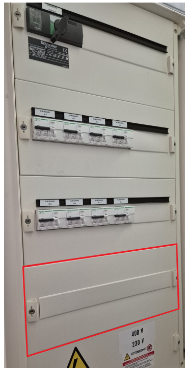
Figura 3.10: Quadro di distribuzione B. In rosso: sezione individuata per la possibile linea privilegiata.
